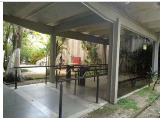
Acesso ao galpão
