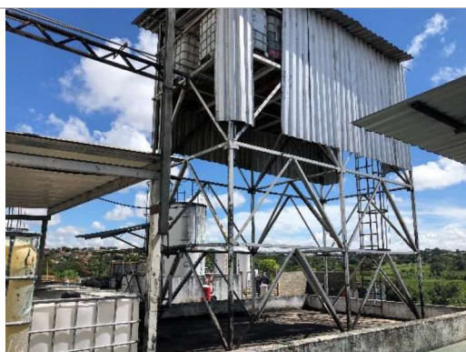
Armazenagem de solventes
