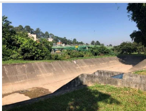
Bacia de contenção de chuvas
