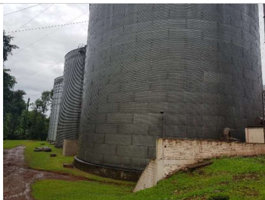
Silos de armazenamento de grãos
