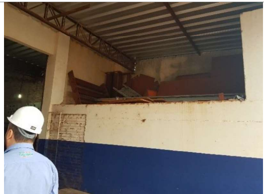
Acesso Almojarifado / Oficina
