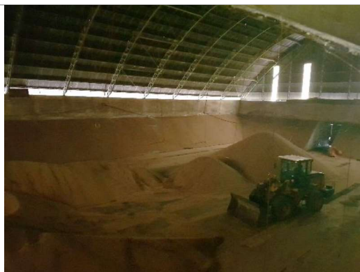
Vista interna do armazém graneleiro
