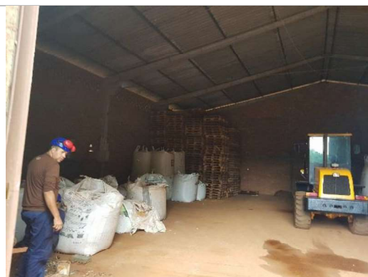
Vista interna do depósito
