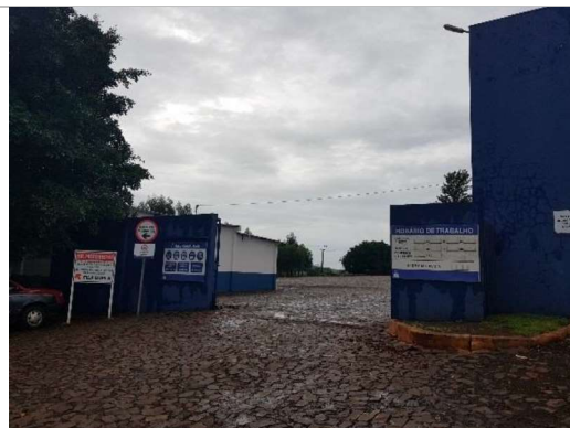
Entrada de veículos
