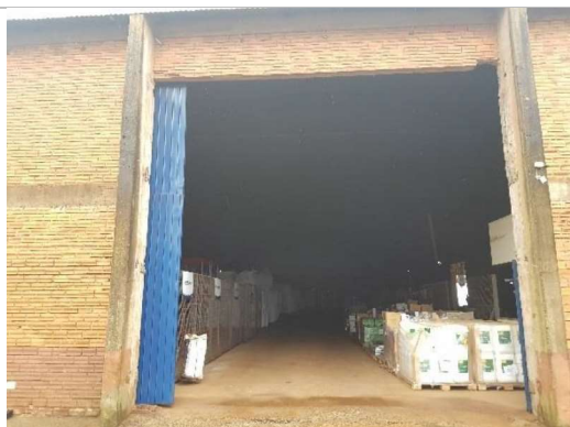
Vista Galpão Armazém
