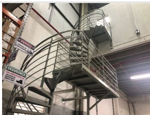
Acesso ao mezanino
