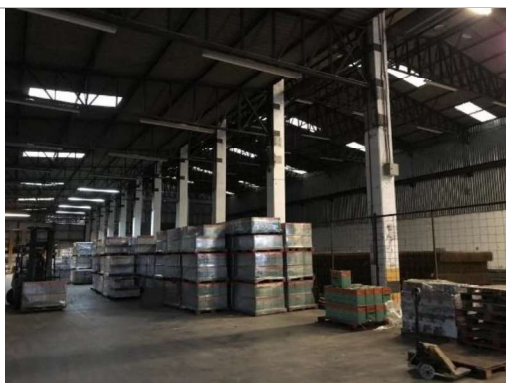
Galpão tintas e vernizes
