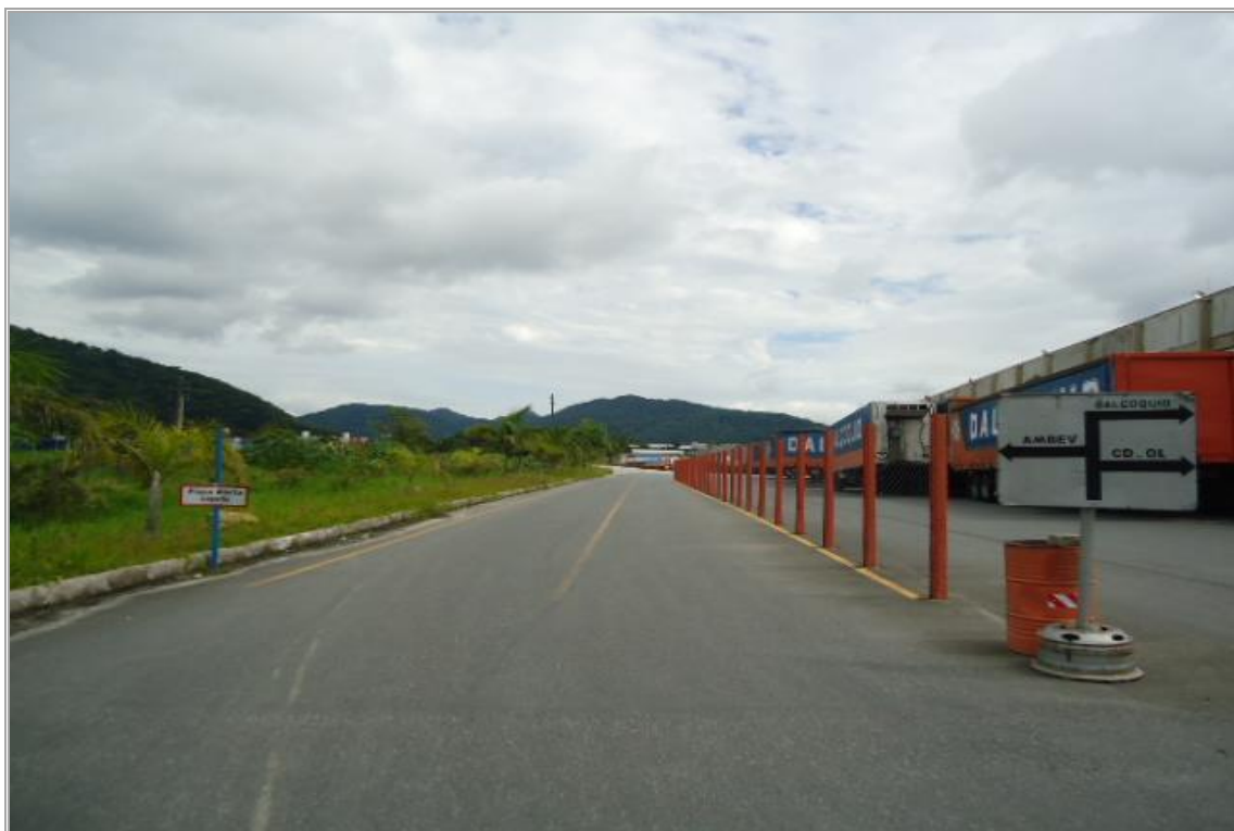
ACESSO ATUAL (RIBEIRÃO DO LADO ESQUERDO E POSTES DE DIVISA DO LADO DIREITO)
