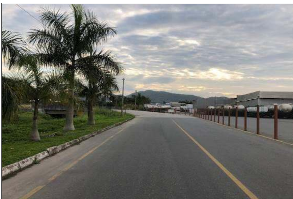
FINAL DO ACESSO E PONTE SOBRE O RIBEIRÃO COM O ACESSO AO INÍCIO/ENTRADA DO IMÓVEL
