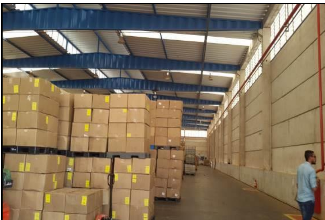
VISTA INTERNA – DEPÓSITO 2
