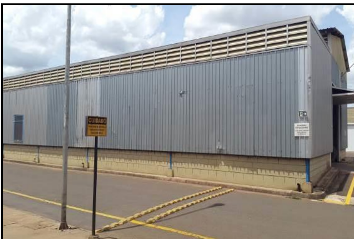
VISTA EXTERNA – DEPÓSITO 1
