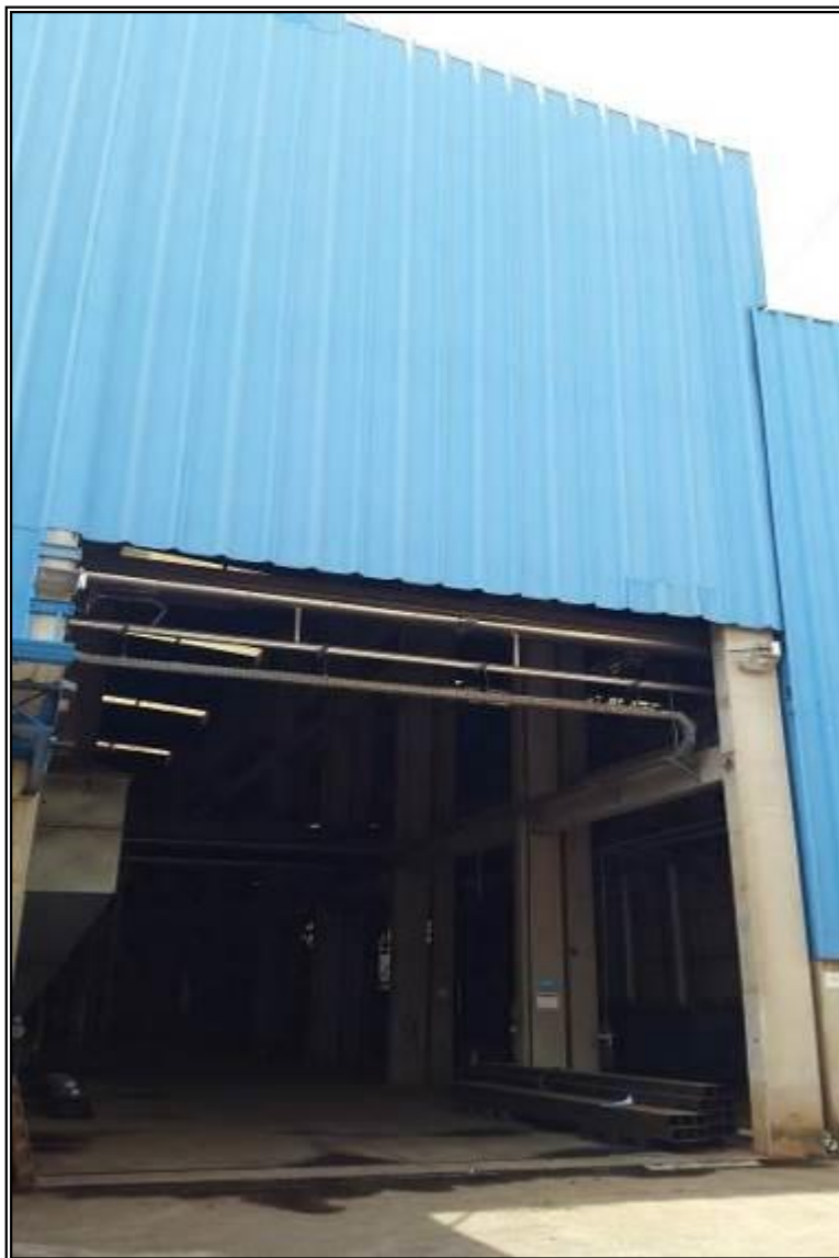
VISTA EXTERNA – CALDEIRAS
