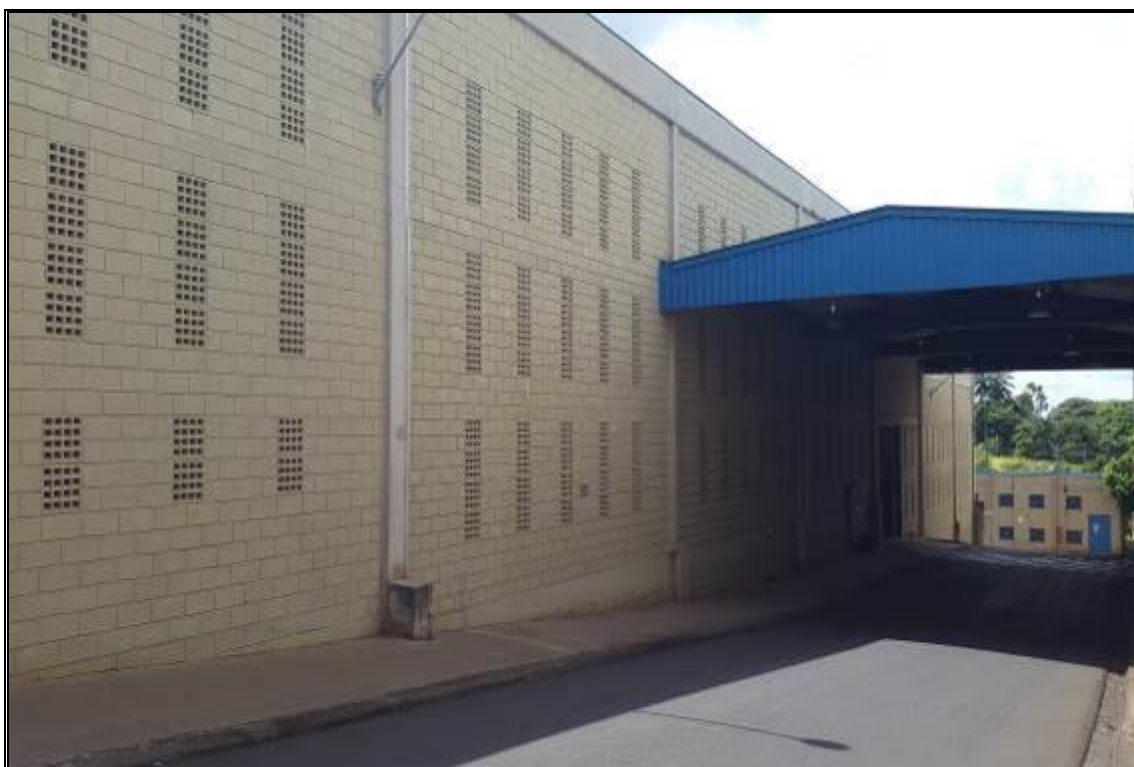
VISTA EXTERNA – SALA DE PANO
