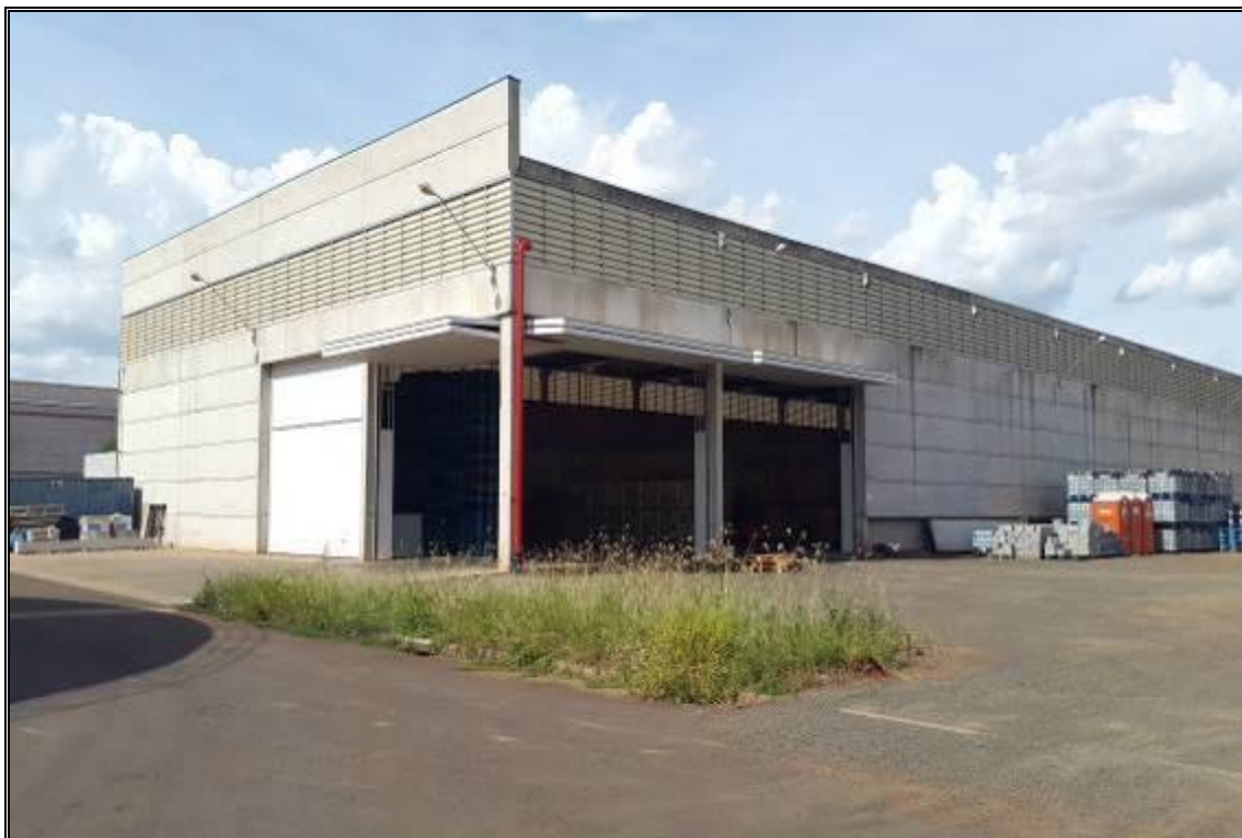
VISTA EXTERNA – DEPÓSITO 2
