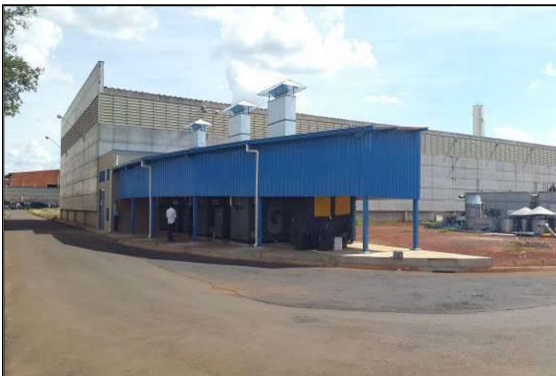
VISTA EXTERNA – DEPÓSITO 2
