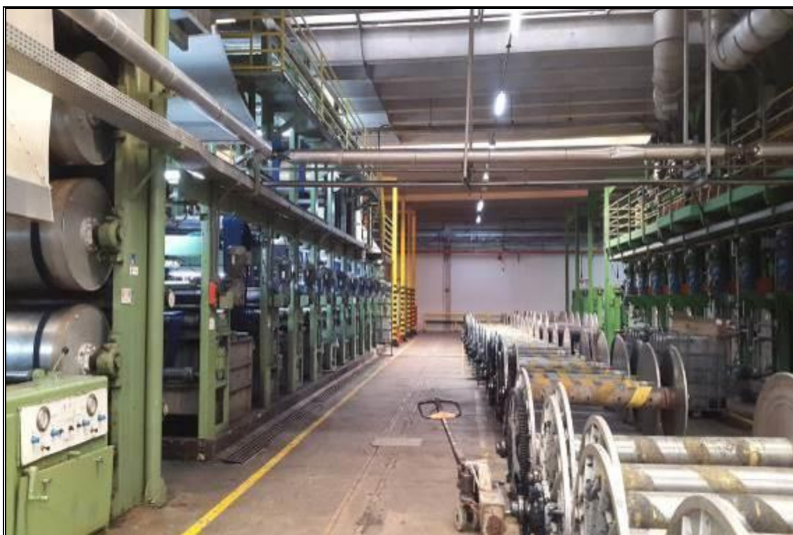
VISTA INTERNA – TECELAGEM 1
