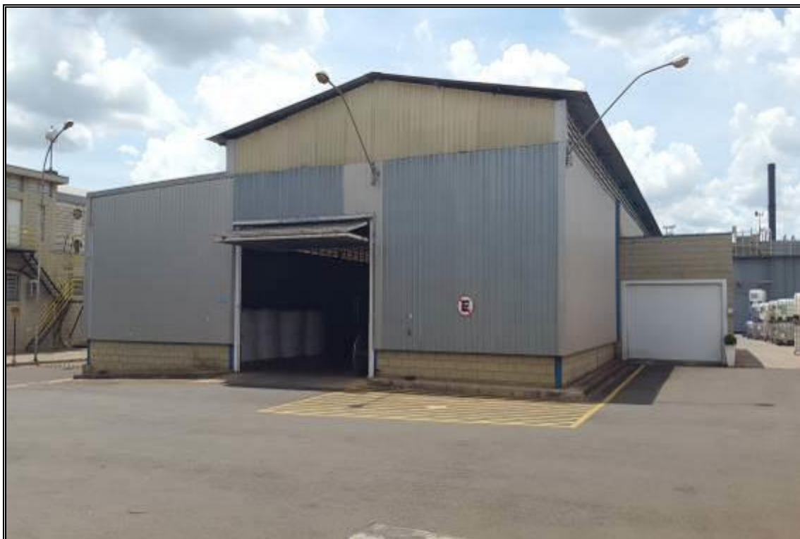
VISTA EXTERNA – DEPÓSITO 1
