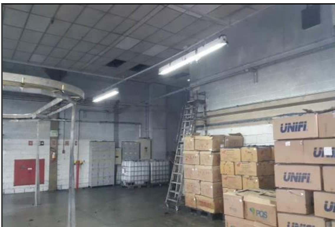
VISTA INTERNA – TECELAGEM 1
