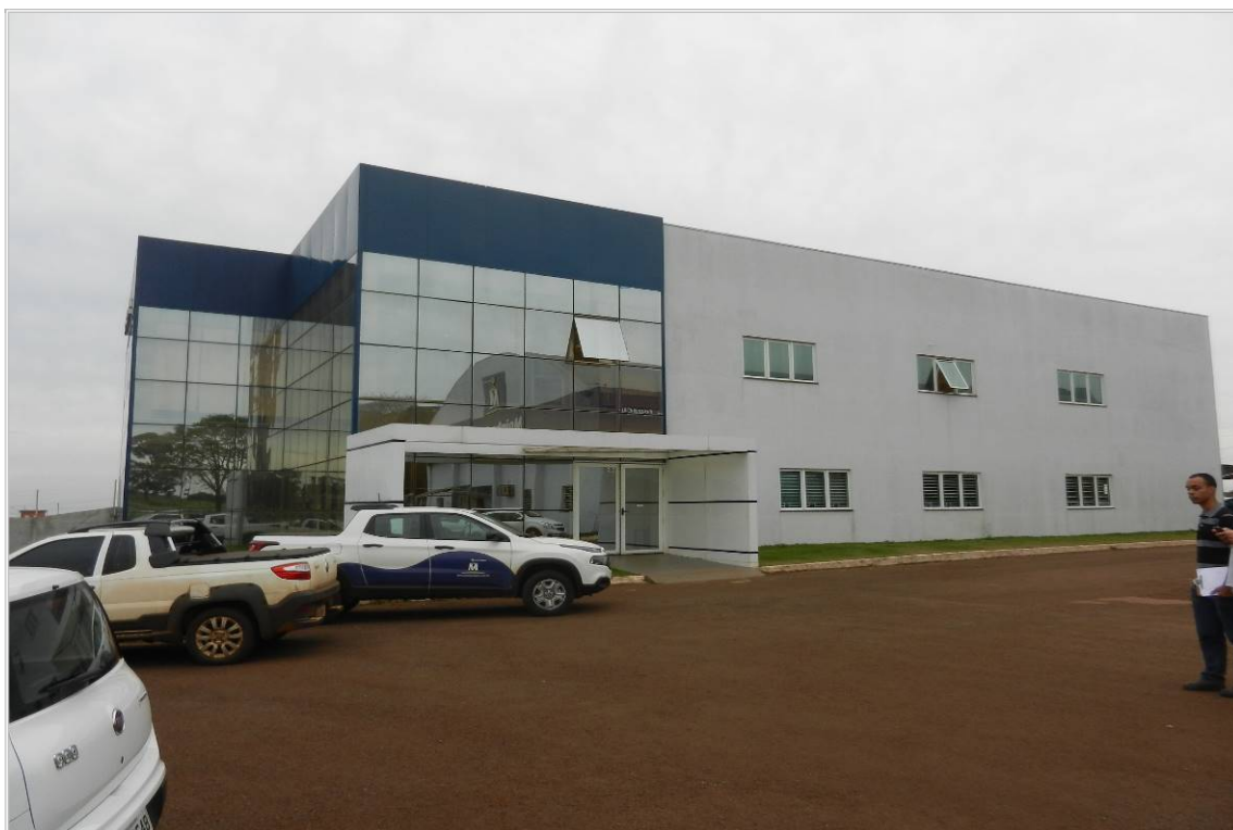
VISTA PARCIAL EXTERNA
