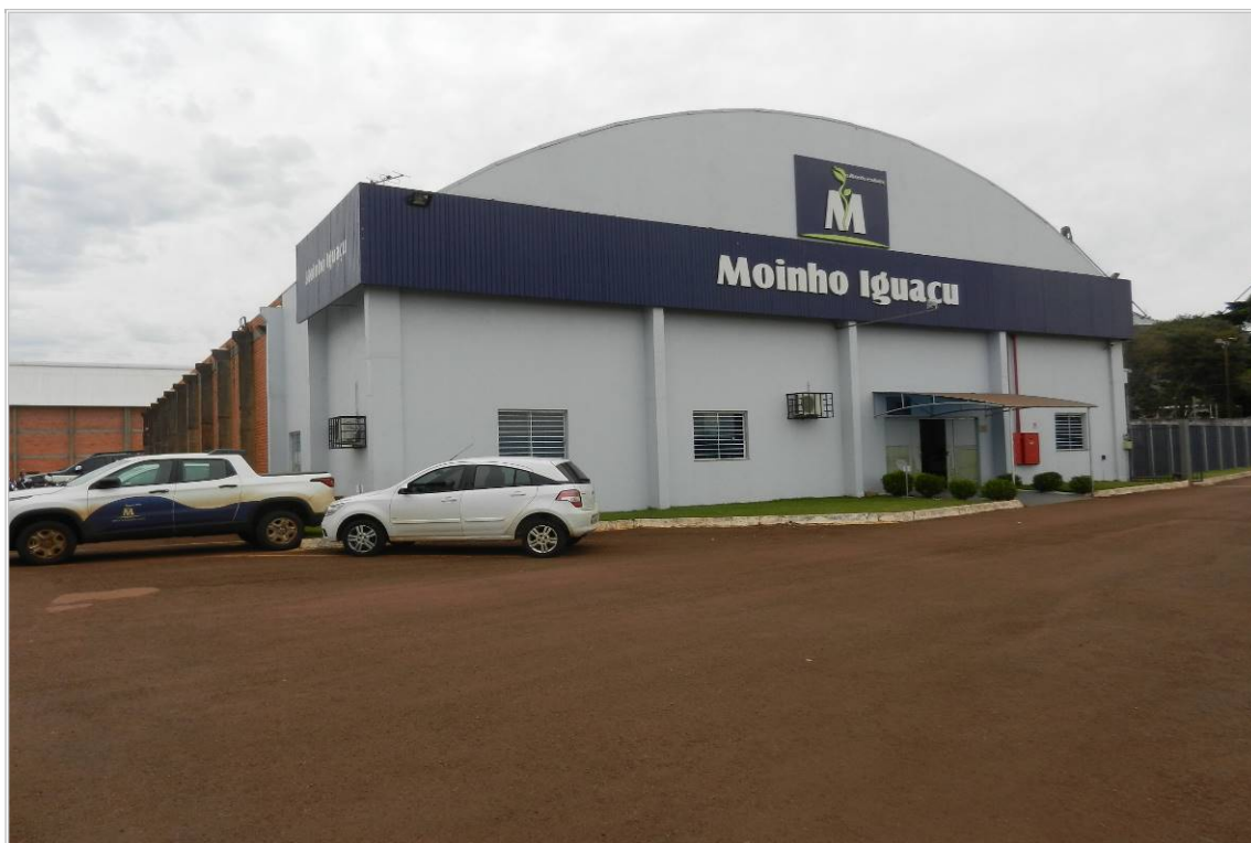
VISTA PARCIAL EXTERNA
