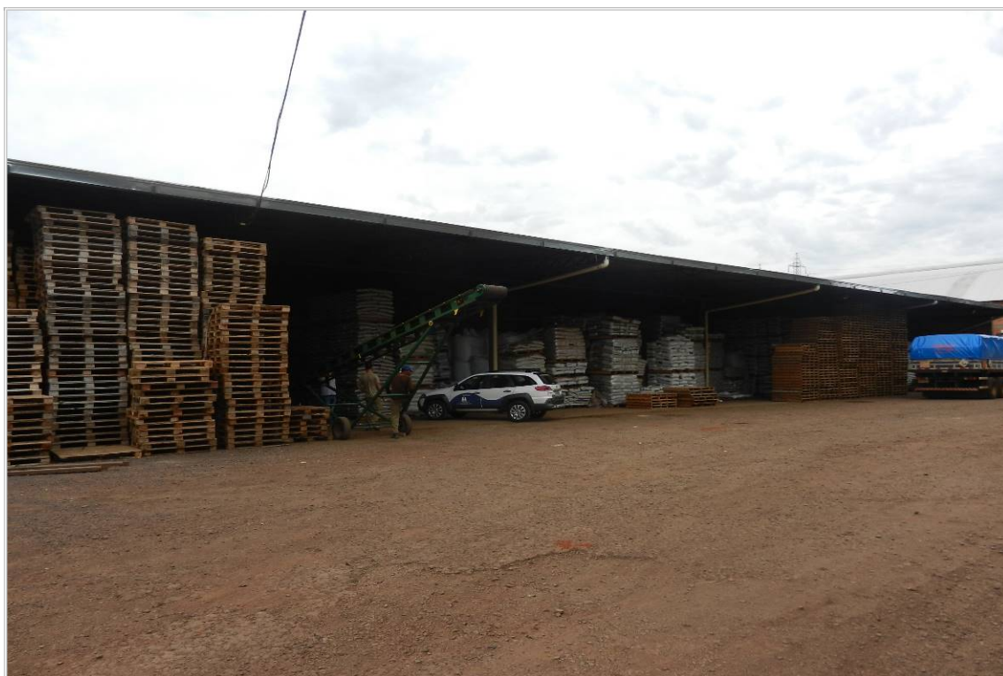
VISTA PARCIAL EXTERNA
