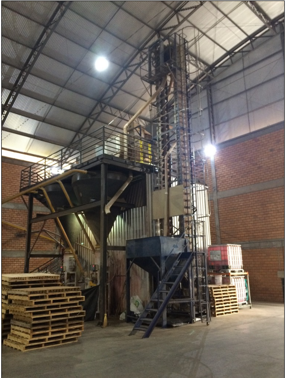
ITEM 1,001 - VISTA DO CENTRO DE TRATAMENTO DE SEMENTES MARCA: MOMENSSO MODELO: TS VHS 10T AUTO SD COMOPOSTO POR: 2 MOEGA DE DESCARGA, 2 ELEVADOR DE CANECA, 1 ESTRUTURA ESTEIRA, 1 ESTRUTURA METÁLICA, 2 SEED MIX, 2 TANQUE TIPO: DOS, 2 SILOS DE ENSAQUE E PAINEL DE CONTROLE
