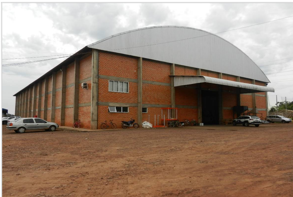
VISTA PARCIAL EXTERNA
