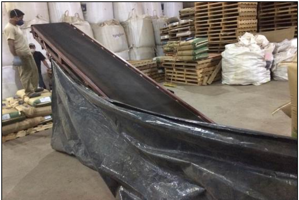
ITEM 1,005 - VISTA DA CORREIRA TRANSPORTADORA MARCA: TN MÁQUINAS E EQUIPAMENTOS MODELO: ETS 4000 SÉRIE: 06201524 COM MOTOR
