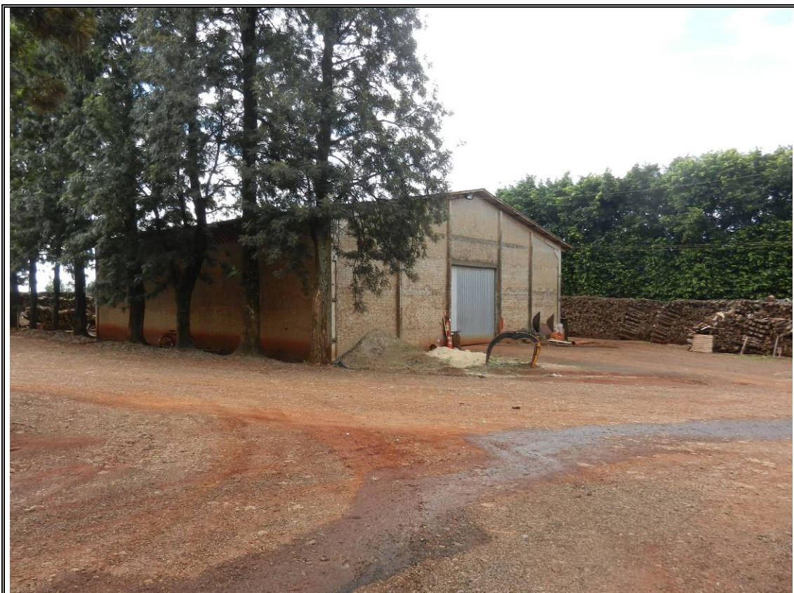
VISTA GERAL DO GALPÃO
