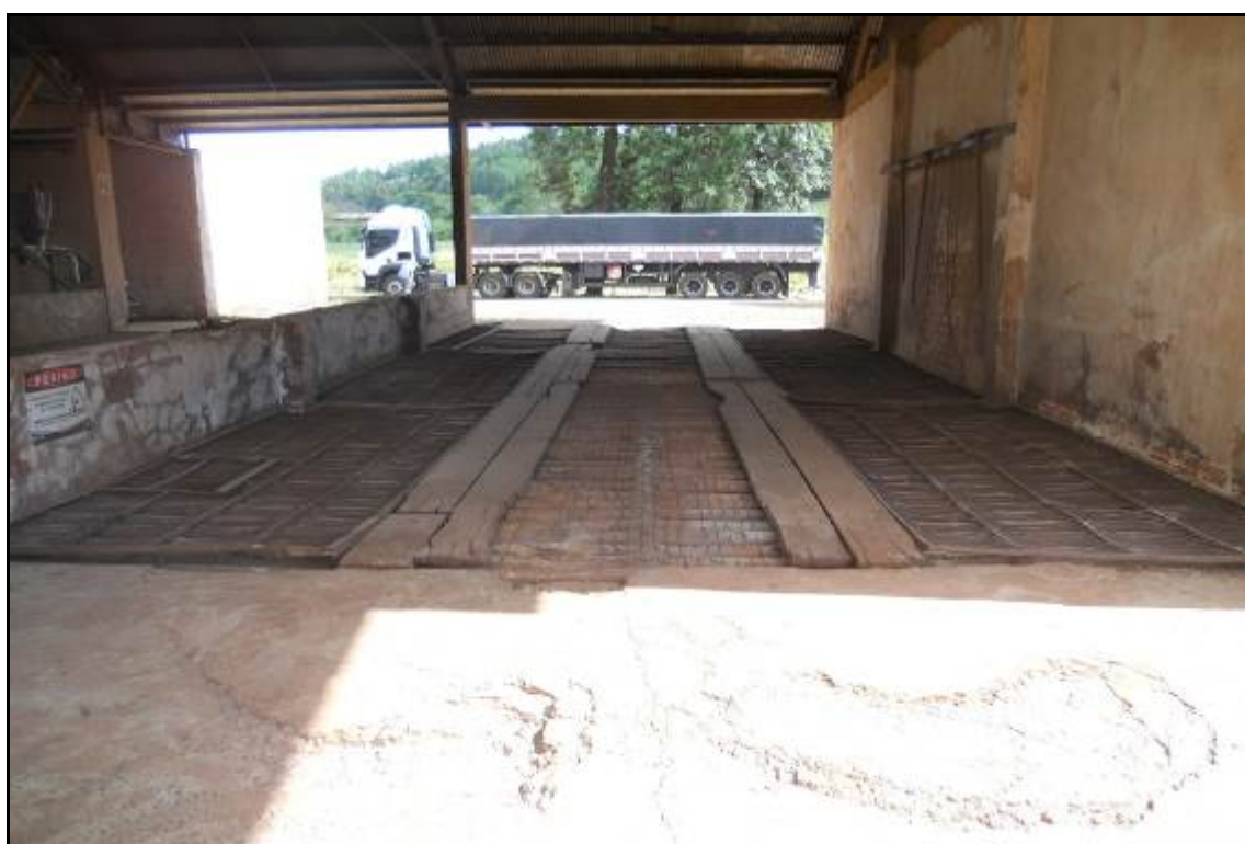
ITEM 1,003 - VISTA DA MOEGA DE DESCARGA DE GRÃOS COM ESTRUTURA EM CONCRETO CAP: 600 TON
