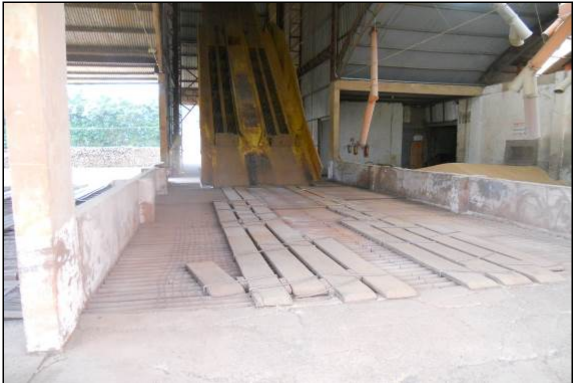
ITEM 1,004 - VISTA DA MOEGA DE DESCARGA DE GRÃOS COM ESTRUTURA EM CONCRETO CAP: 600 TON
