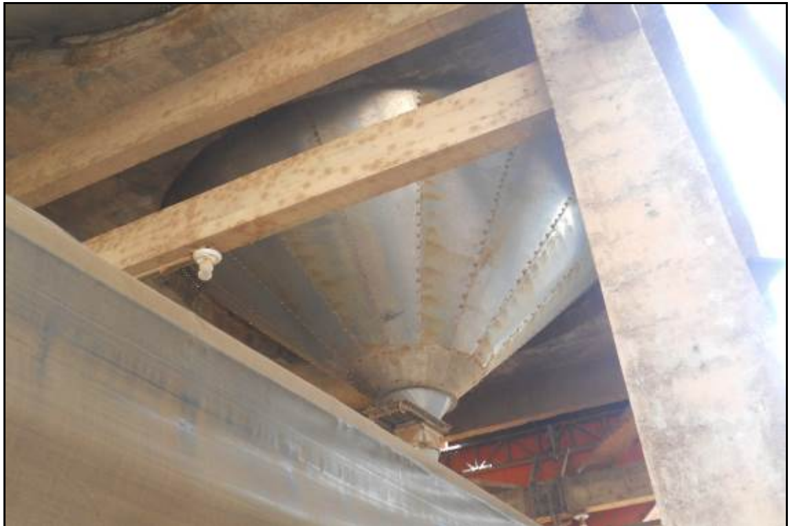
ITEM 1,025 - VISTA DO SILO DE EXPEDIÇÃO
