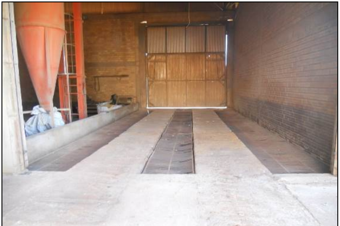
ITEM 2,002 - VISTA DA MOEGA DE DESCARGA DE GRÃOS COM ESTRUTURA EM CONCRETO CAP: 180 TON
