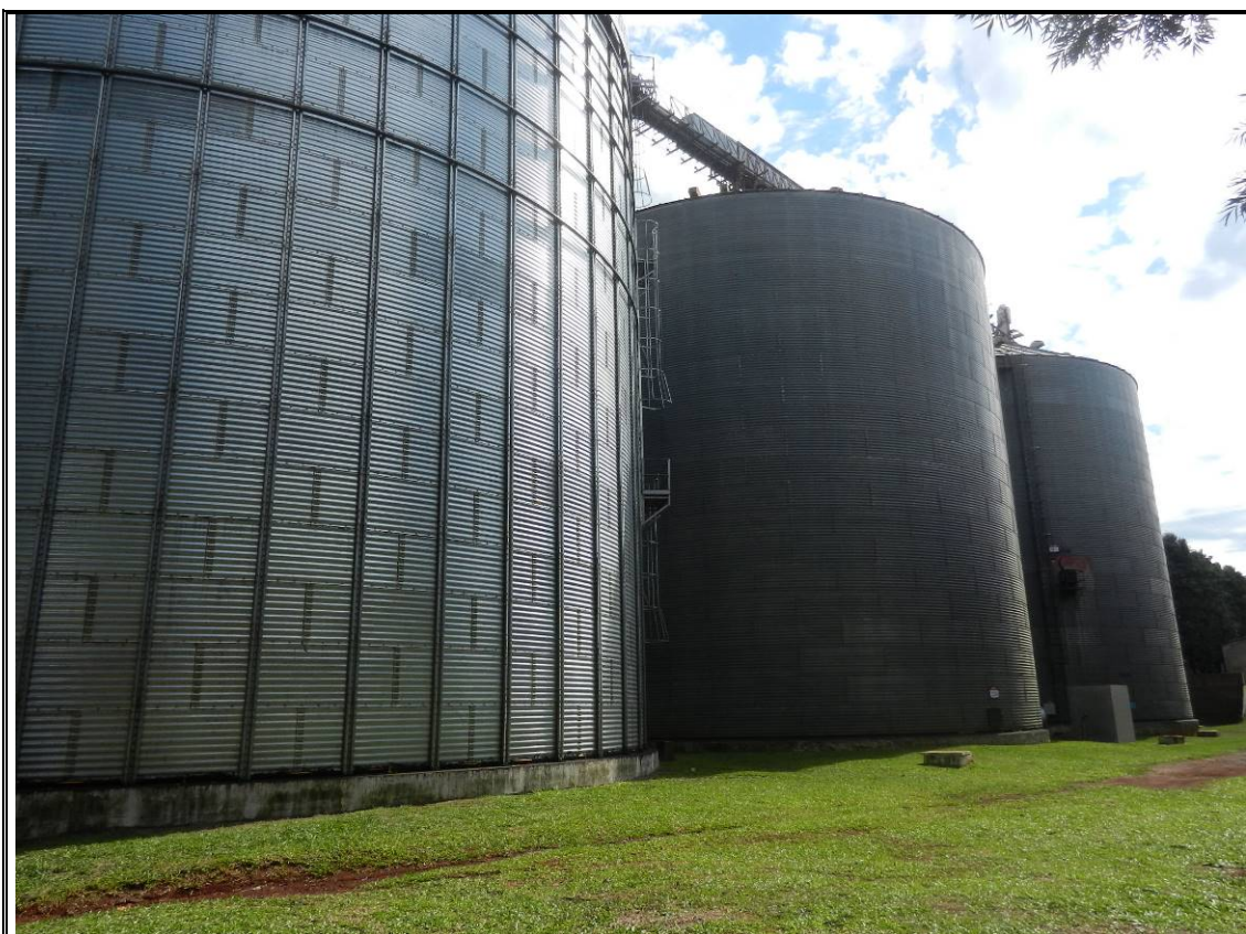
VISTA PARCIAL DAS BASES DOS SILOS
