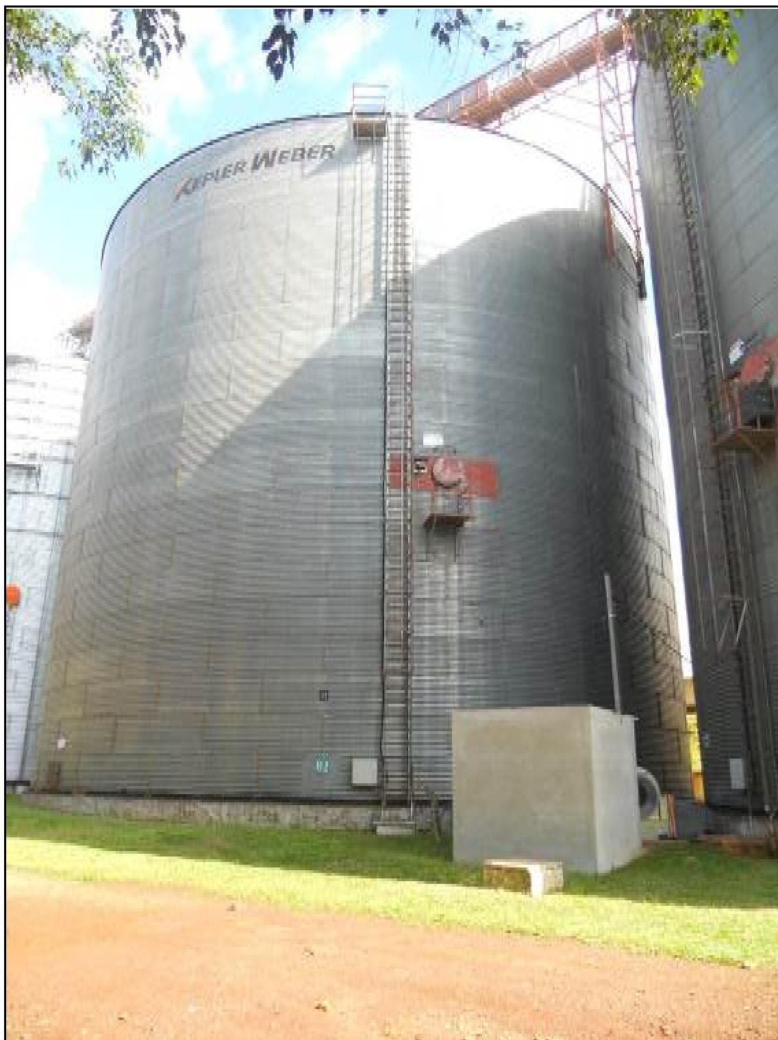
ITEM 1,034 - VISTA DO SILO DE ARMAZEMAGEM METÁLICO MARCA: KELPLER WEBER CAP: 6.000 COM VENTILADOR CENTRÍFUGO E SISTEMA DE TERMOMETRIA Nº 2
