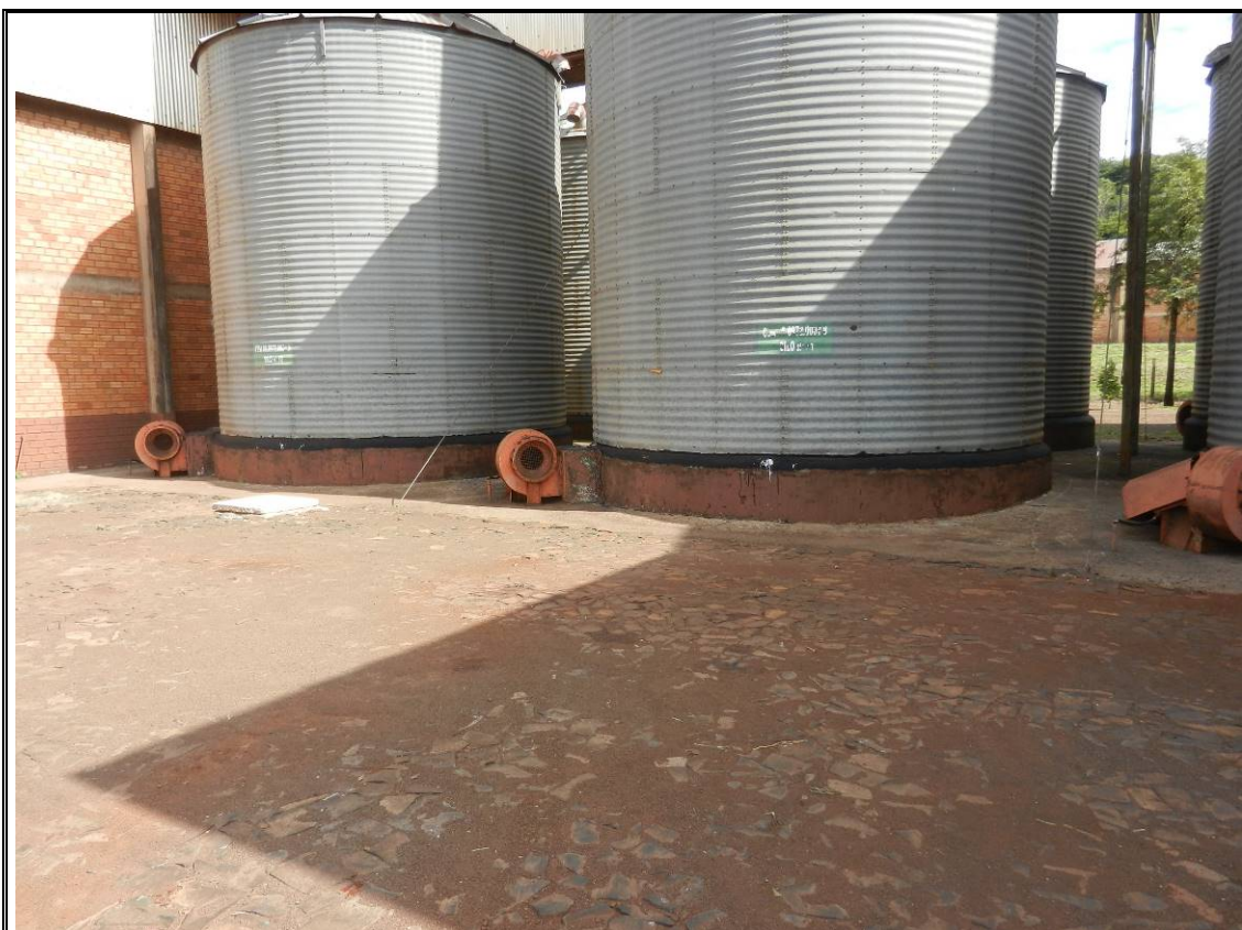
VISTA PARCIAL DAS BASES DOS SILOS
