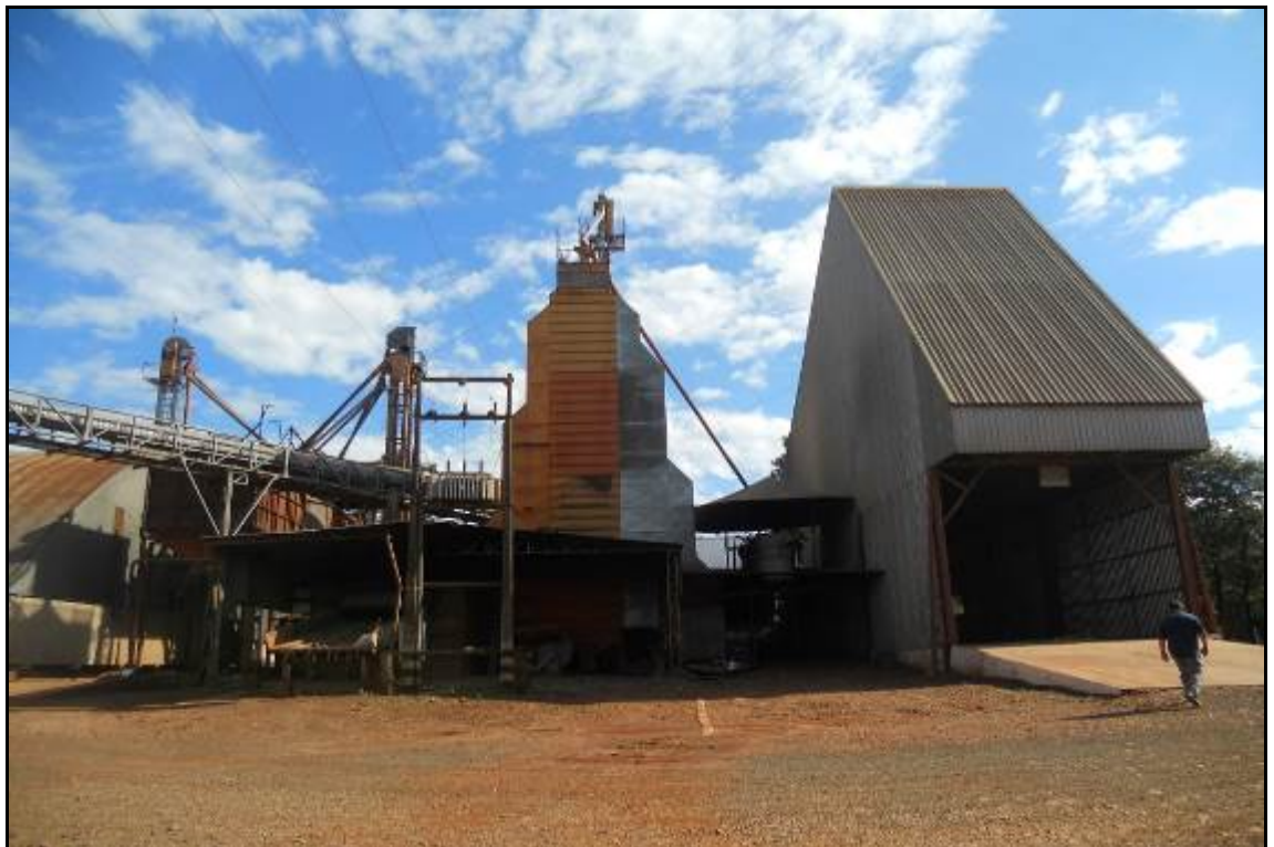
ITEM 1,001 - VISTA DA UNIDADE ARMAZENADORA DE GRÃOS CAP: 30.000 TON COMPREENDENDO OS EQUIPAMENTOS RELACIONADOS NOS ITENS 1,002 A 1,035
