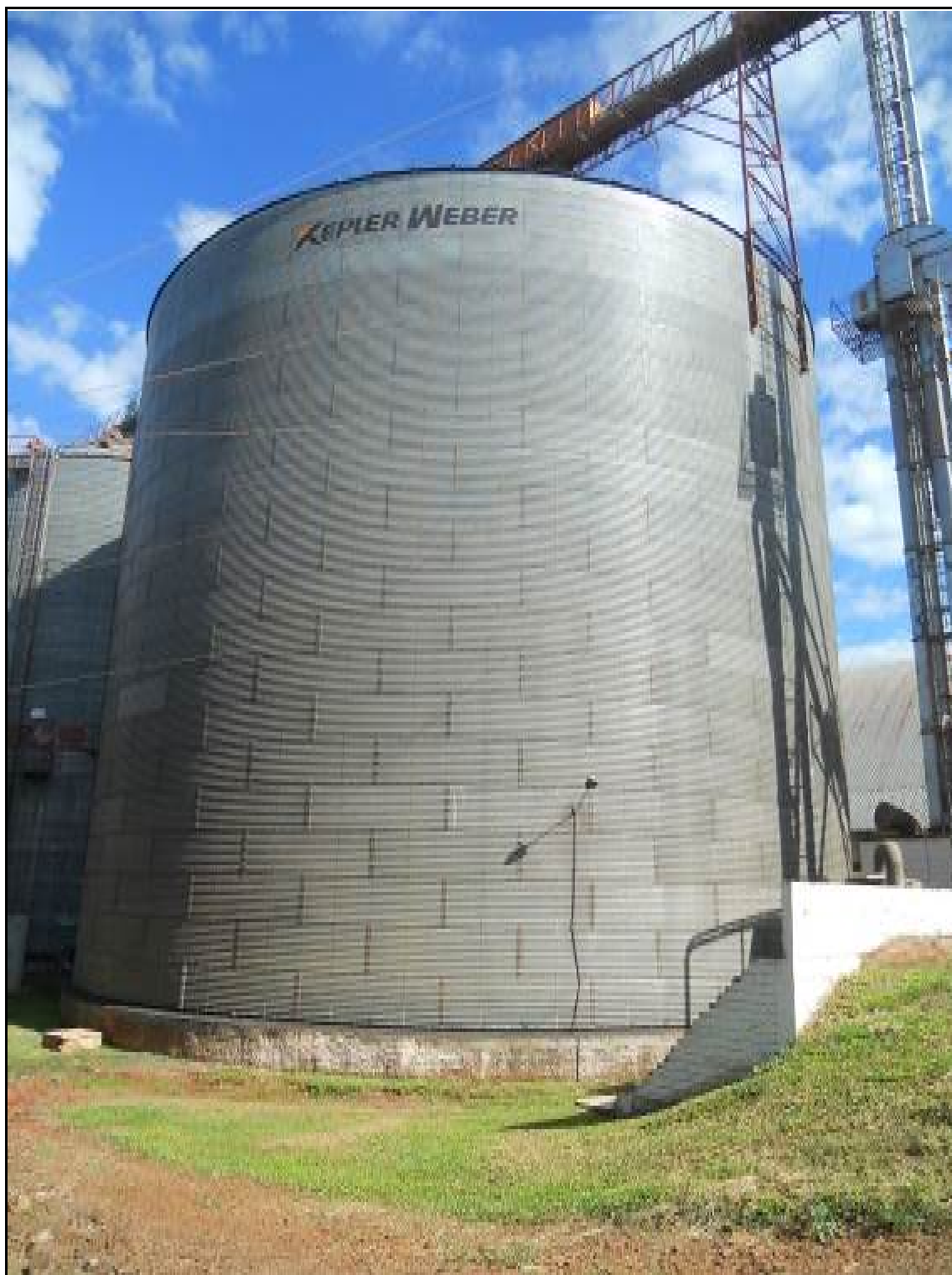
ITEM 1,033 - VISTA DO SILO DE ARMAZEMAGEM METÁLICO MARCA: KELPLER WEBER CAP: 6.000 COM VENTILADOR CENTRÍFUGO E SISTEMA DE TERMOMETRIA Nº 1
