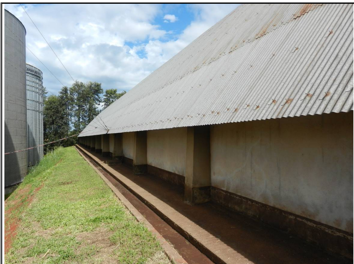
VISTA PARCIAL EXTERNA
