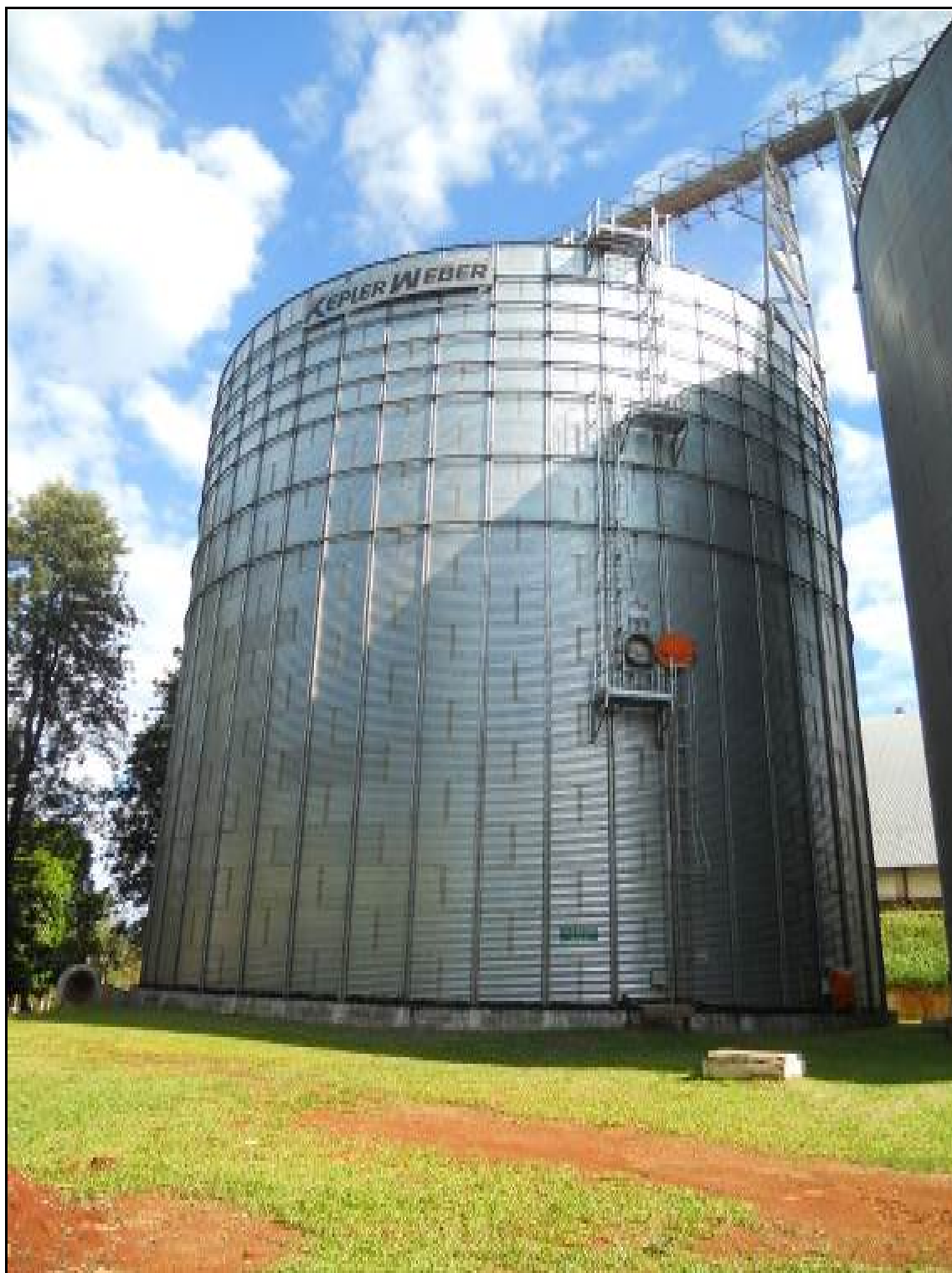
ITEM 1,035 - VISTA DO SILO DE ARMAZEMAGEM METÁLICO MARCA: KELPLER WEBER CAP: 6.000 COM VENTILADOR CENTRÍFUGO E SISTEMA DE TERMOMETRIA Nº 3
