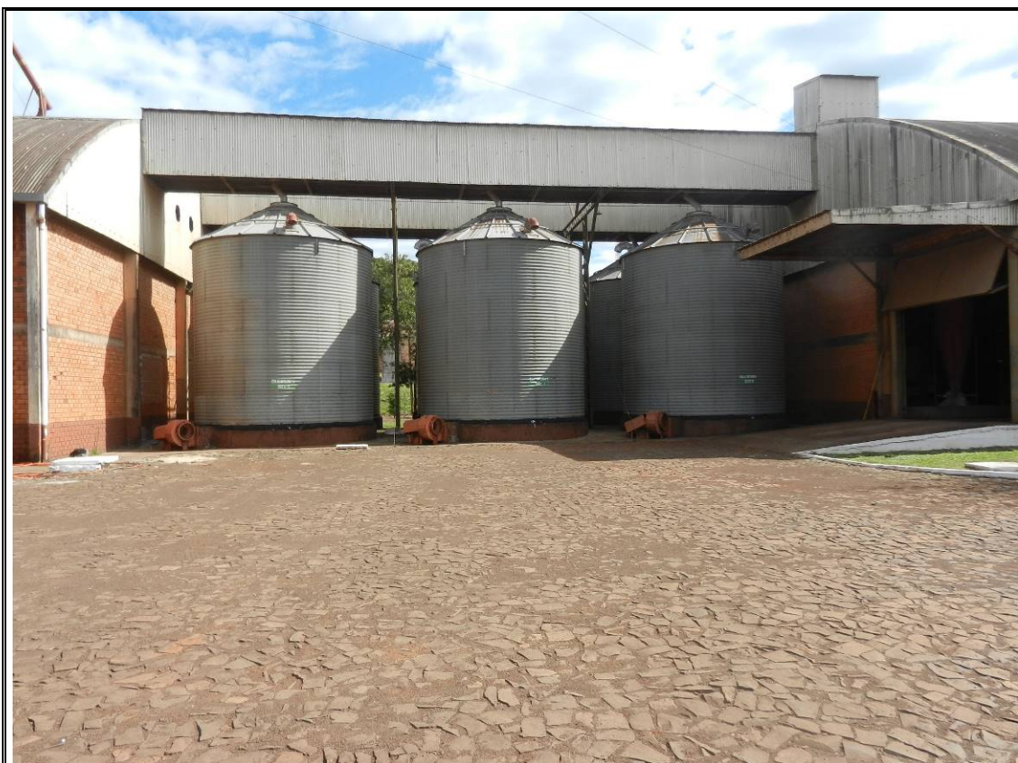
VISTA PARCIAL DAS BASES DOS SILOS
