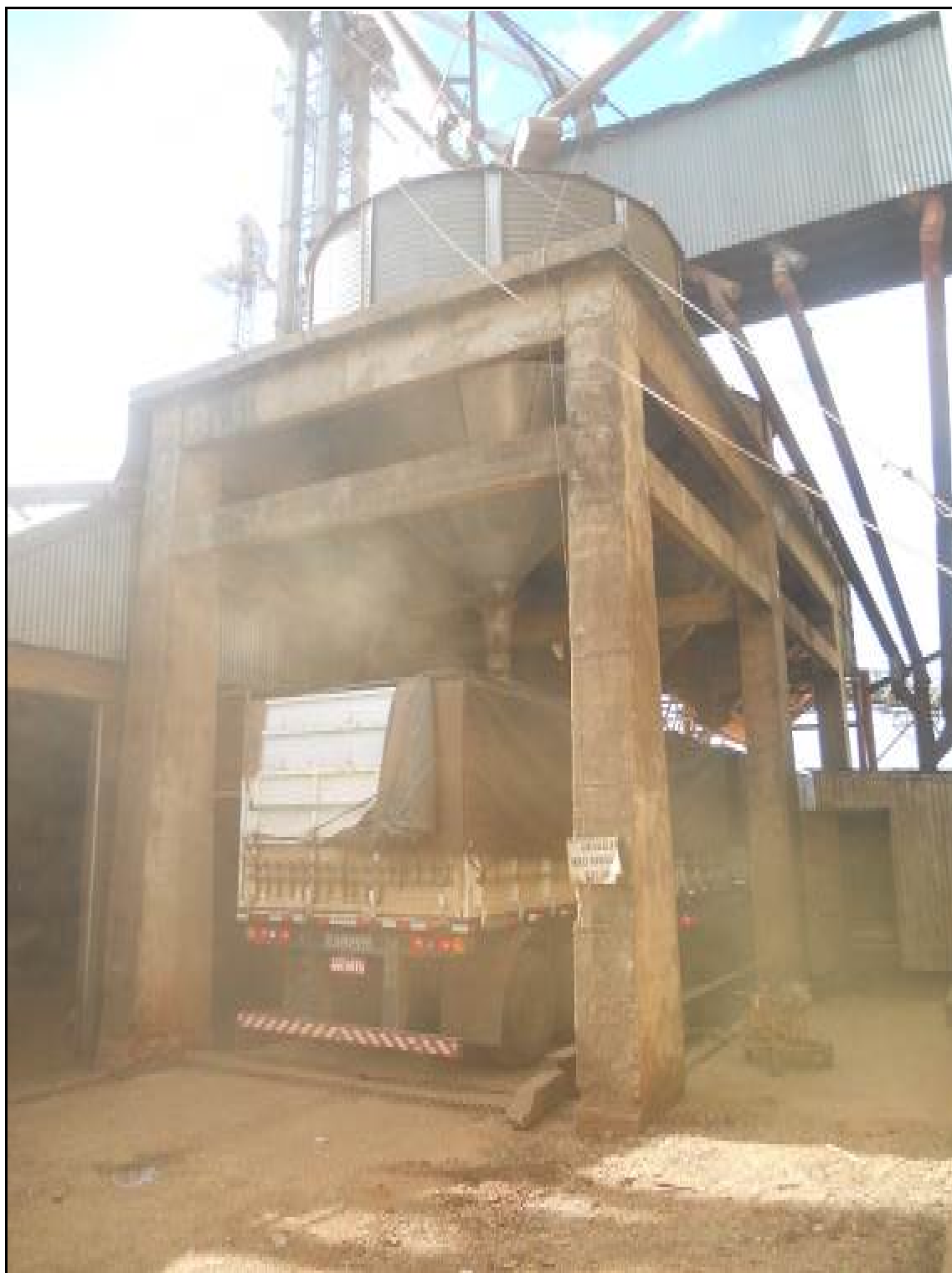
ITEM 1,024 - VISTA DO SILO DE EXPEDIÇÃO
