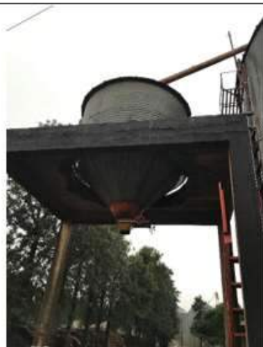
Vista Silo de Exposição
