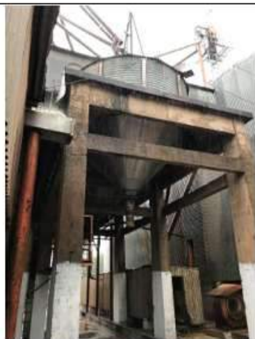
Vista Silo de Expedição
