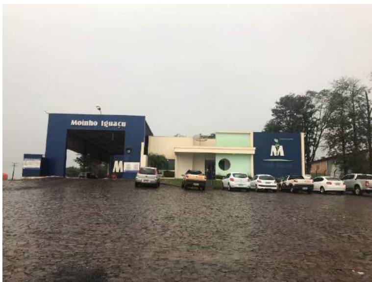
Vista da frente principal do imóvel
