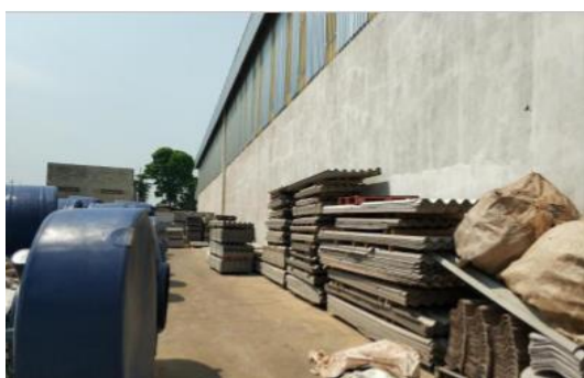
Galpão – Depósito Geral (Vista L.D)
