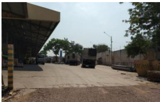
Pátio de Manobras
