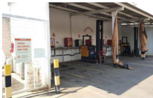
Reservatório de Gás e Garagem para Empilhadeiras
