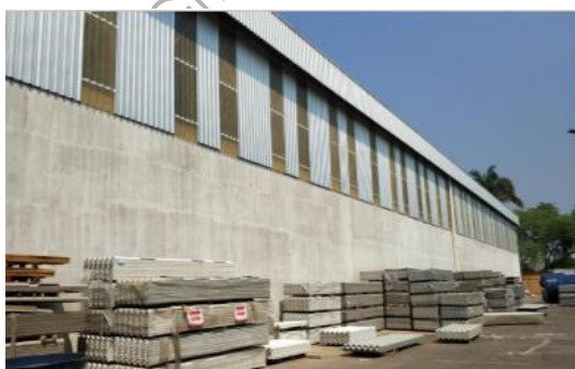
Galpão – Depósito Geral (Vista L.D.)
