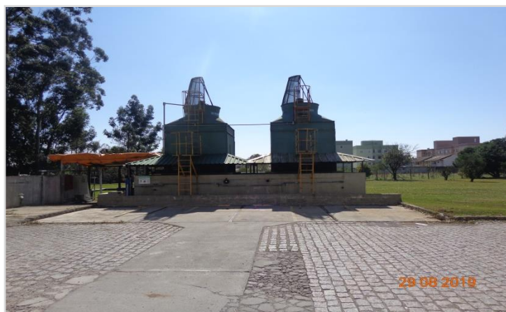
Via de Circulação Interna
