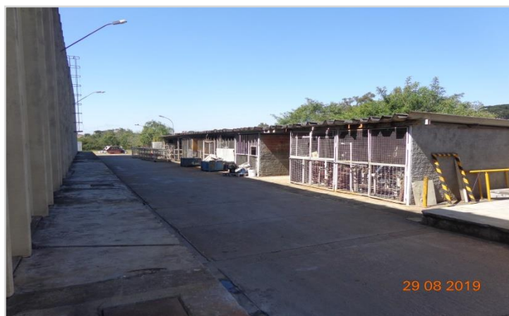
Via de Circulação Interna
