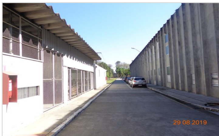
Via de Circulação Interna
