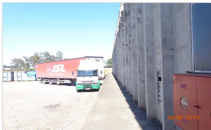
Via de Circulação Interna
