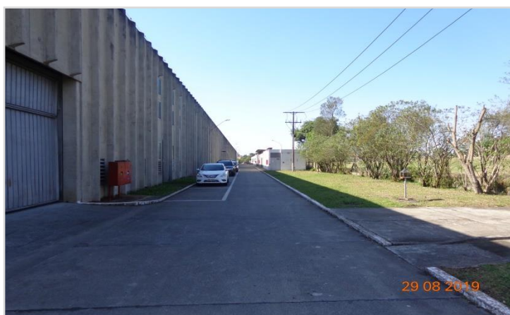
Via de Circulação Interna
