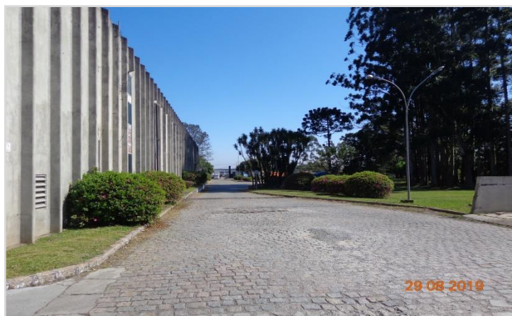
Via de Circulação Interna
