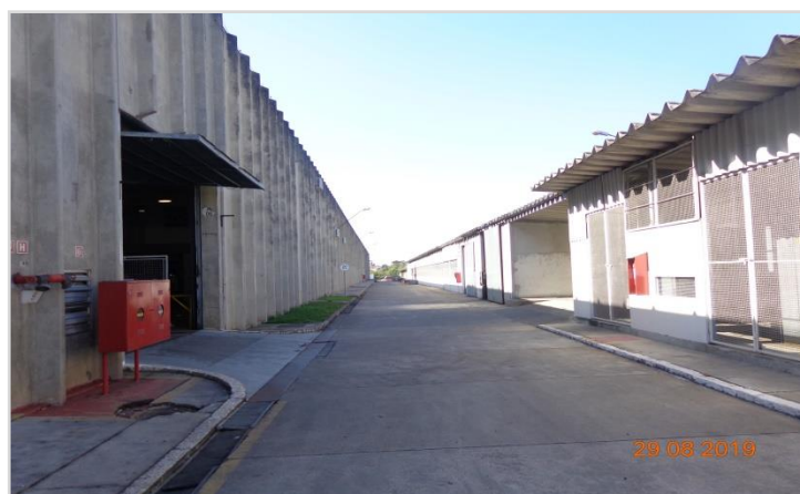
Via de Circulação Interna
