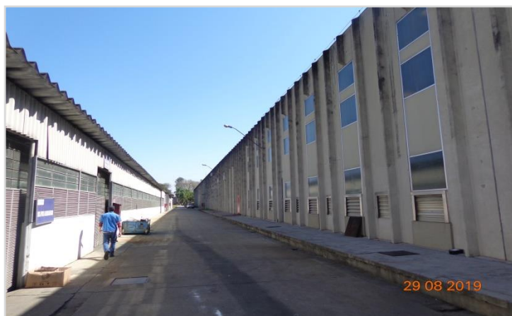
Via de Circulação Interna
