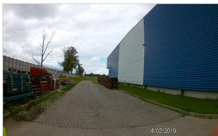
Via de Circulação
