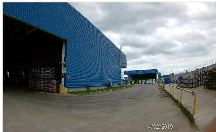
Via de Circulação
