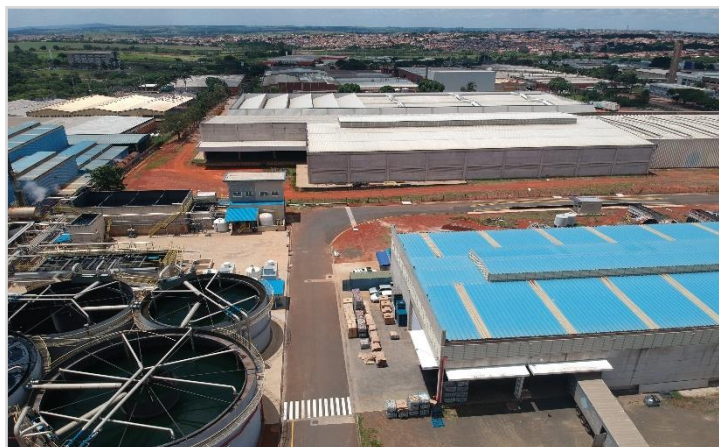
ETE - Vista Aérea
