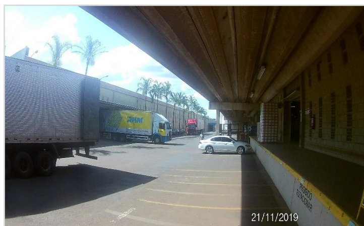
Docas – Galpão Acabamento/ Finalização
