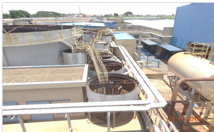
ETE - Vista Aérea
