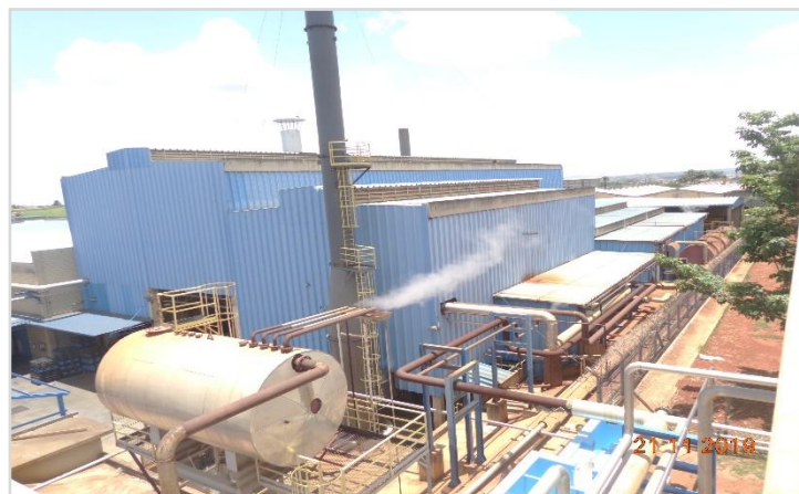
ETE - Vista Aérea
