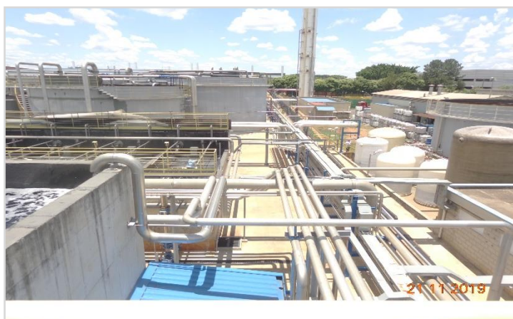
ETE - Vista Aérea
