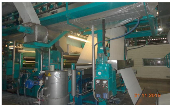
Galpão Tingimento e Engomagem
