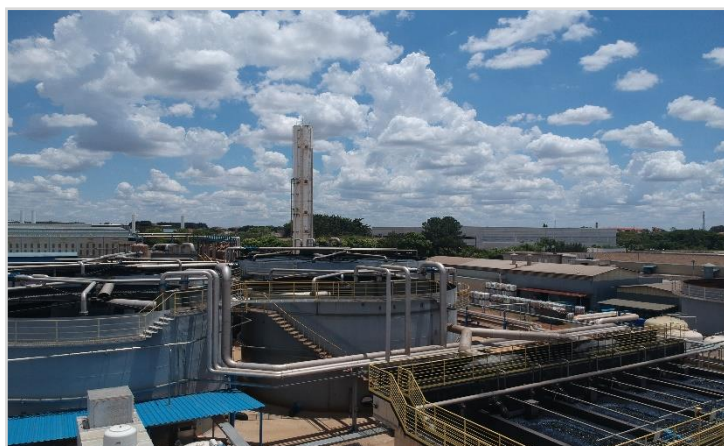
ETE - Vista Aérea
