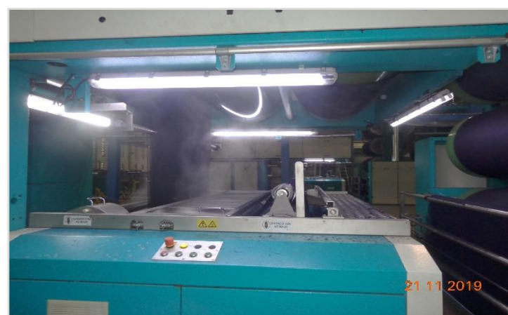
Galpão Tingimento e Engomagem
