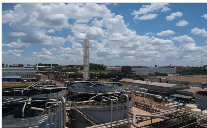
ETE - Vista Aérea
