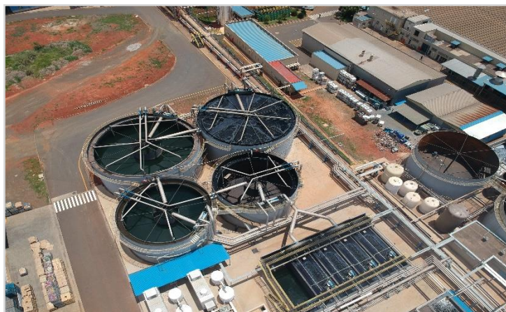
ETE - Vista Aérea
