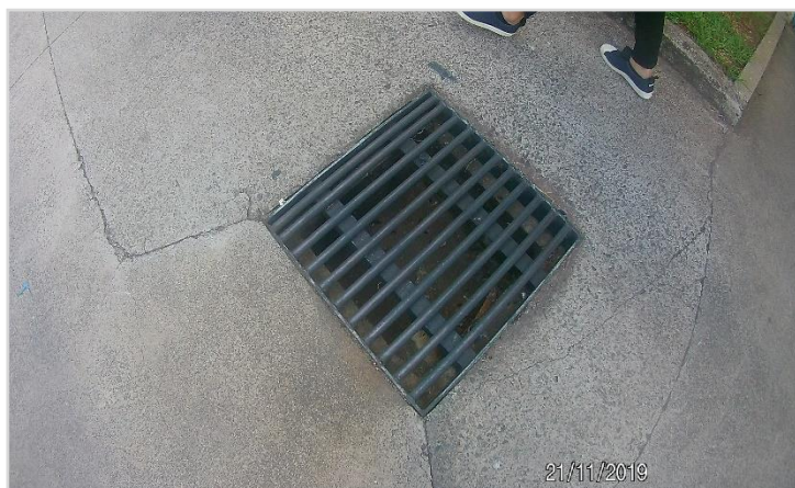
Galeria de água pluvial
