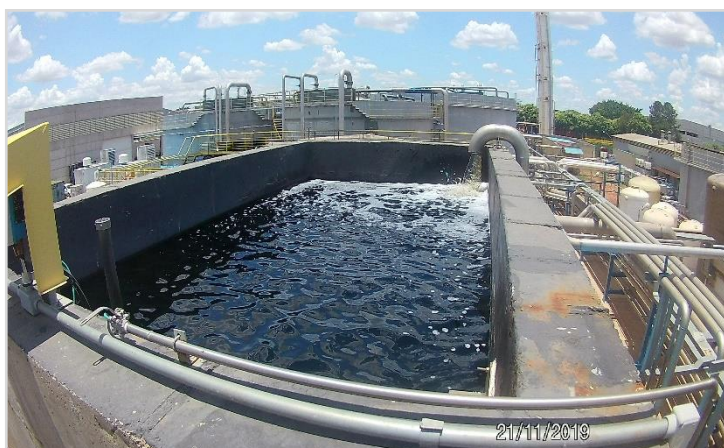
ETE - Vista Aérea
