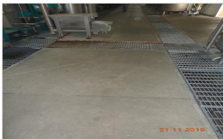
Galpão Tingimento e Engomagem
