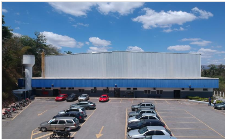
Estacionamento de Veículos
