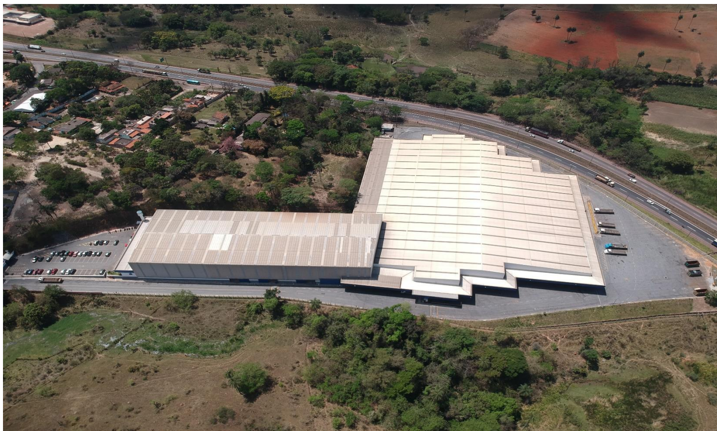
Vista Aérea - Galpão
