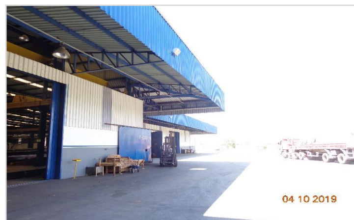
Galpão Produção – Área Externa
