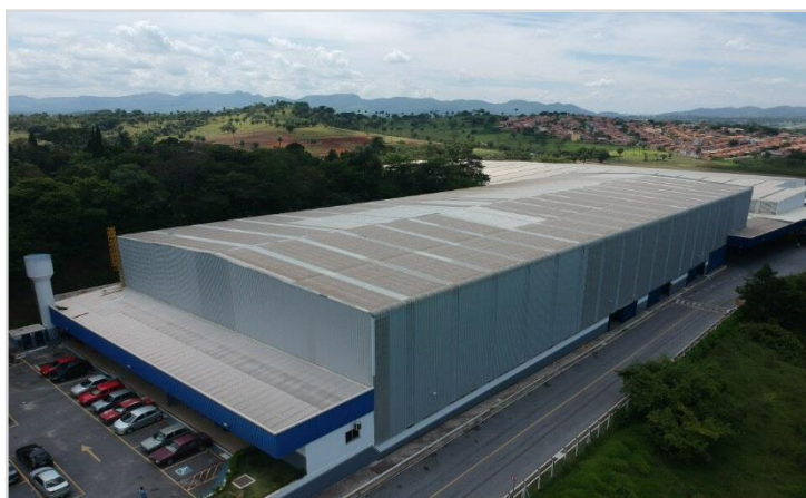
Vista Aérea Galpão
