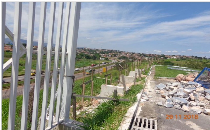
Antes – Início substituição do fechamento perimetral
