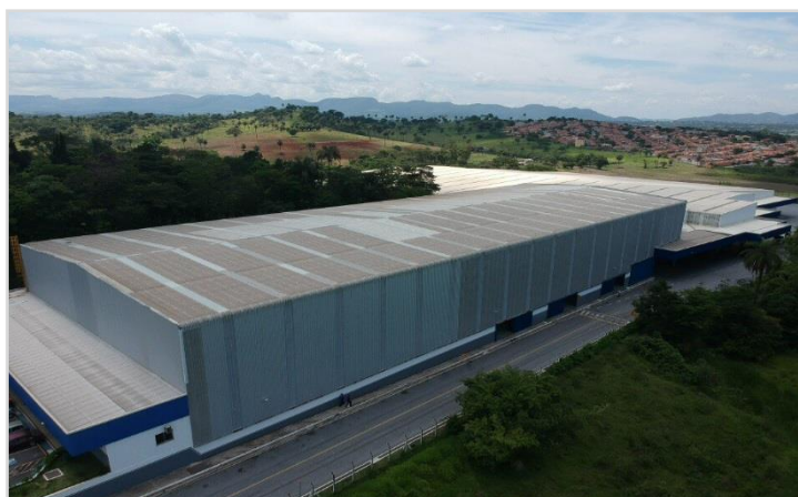
Vista Aérea Galpão
