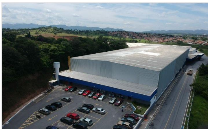
Vista Aérea Galpão
