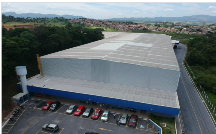
Antes – Pintura parcial da platibanda da fachada
