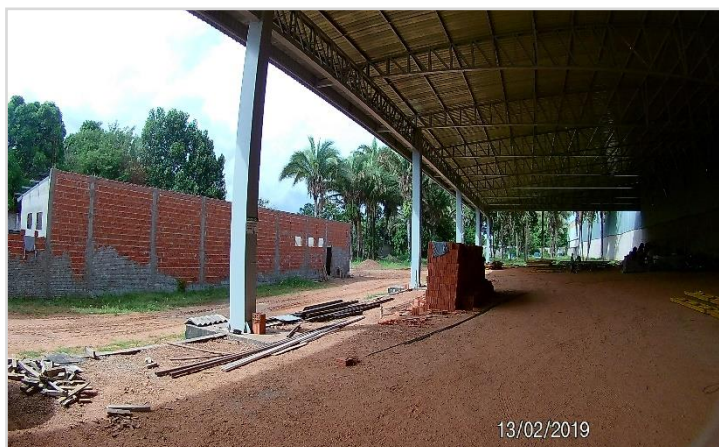
Ampliação Galpão e Construção de Novo Adm
