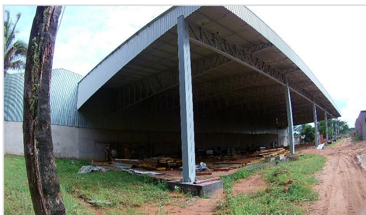
Ampliação do Galpão
