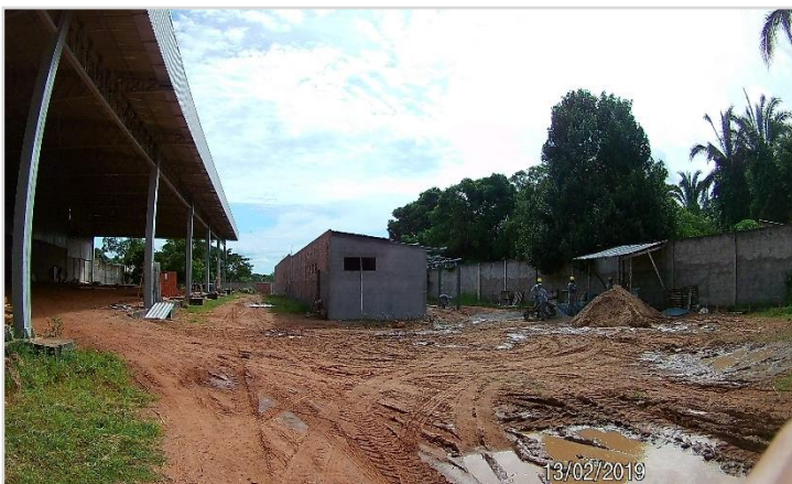
Construção de Novo Adm.
