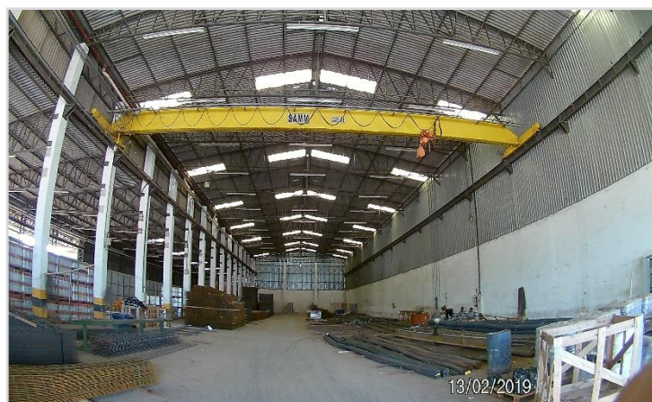
Galpão Estoque Barras de Aço e Vergalhões
