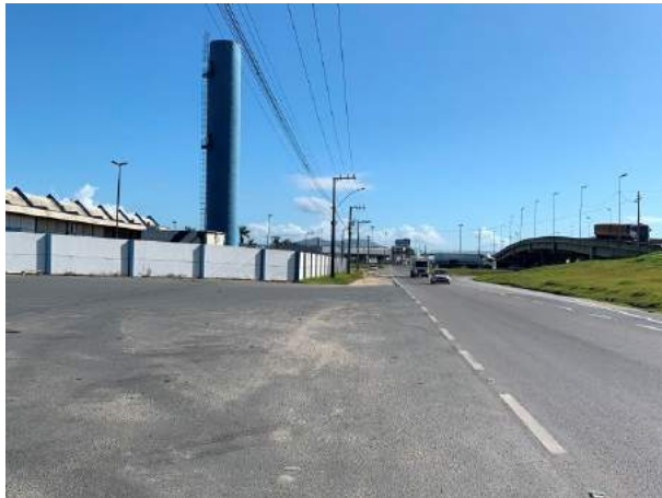
Rodovia Governador Mário Covas – Via de Acesso pelo Imóvel Terceiro.
