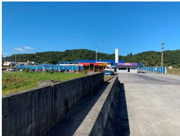
Vista da Fachada do Imóvel Avaliando.
