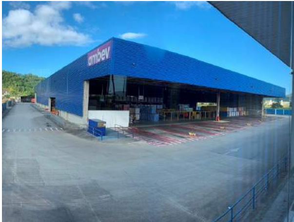
Características Externas do Centro de Distribuição.
