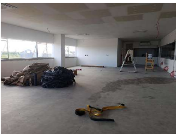
Características Internas do Imóvel Avaliando.
