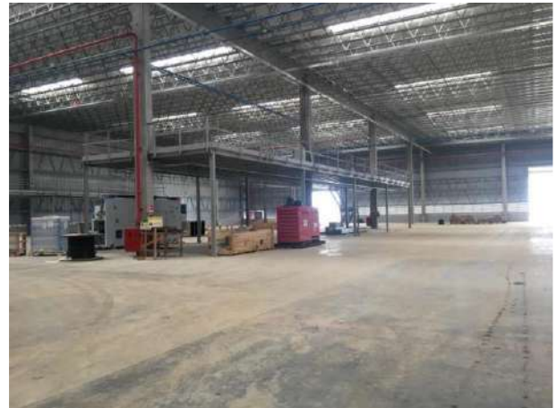
Características Internas do Imóvel Avaliando.
