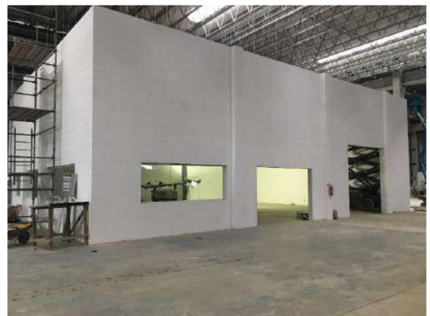
Características Internas do Imóvel Avaliando.
