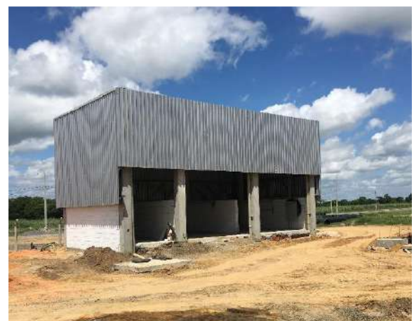
Características Gerais do Imóvel Avaliando.
