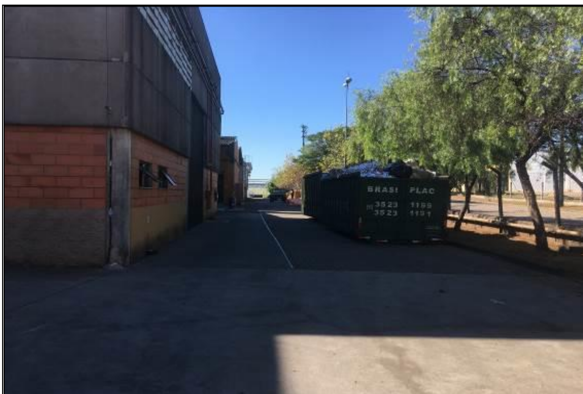
VISTA GERAL DO PÁTIO EXTERNO
