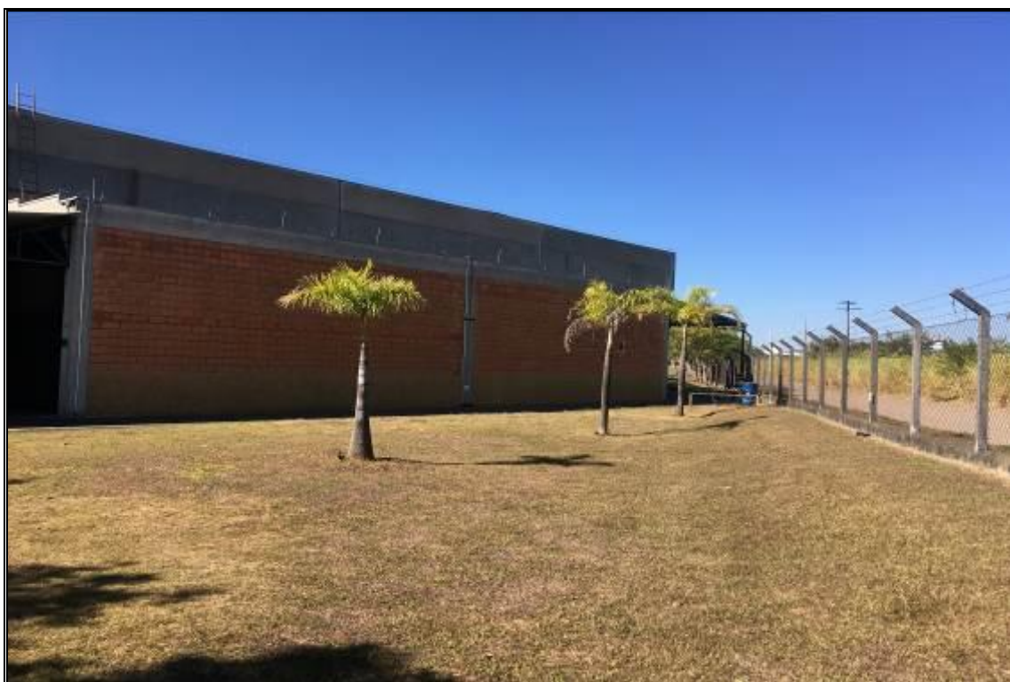
VISTA GERAL EXTERNA DO GALPÃO
