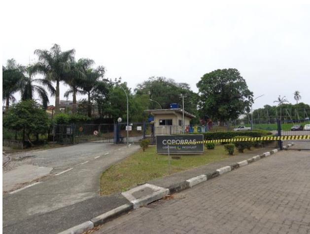
Vista Externa do Imóvel Avaliando.
