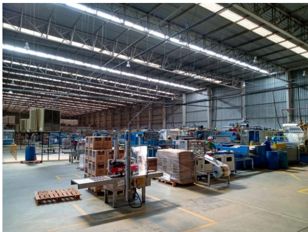
Características Internas do Imóvel Avaliando.
