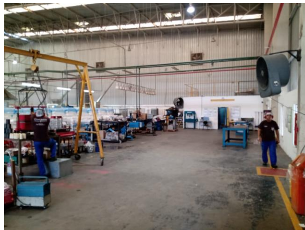
Características Internas do Imóvel Avaliando.
