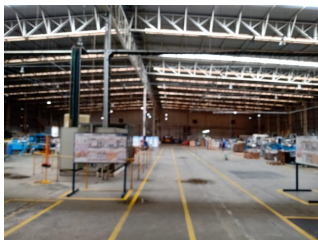
Características Internas do Imóvel Avaliando.
