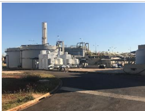
Central de Tratamento de Água
