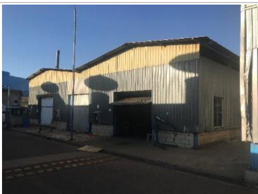
Galpão Apoio - Manutenção
