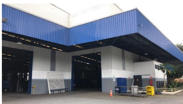
Vista externa do galpão
