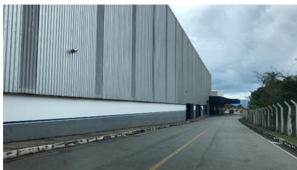
Vista externa do galpão
