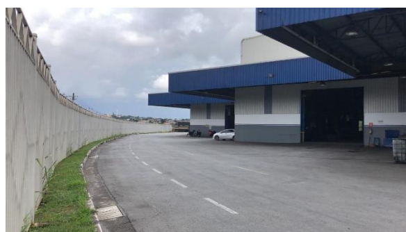
Vista externa do galpão
