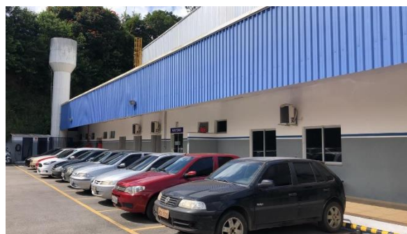
Vista externa do galpão
