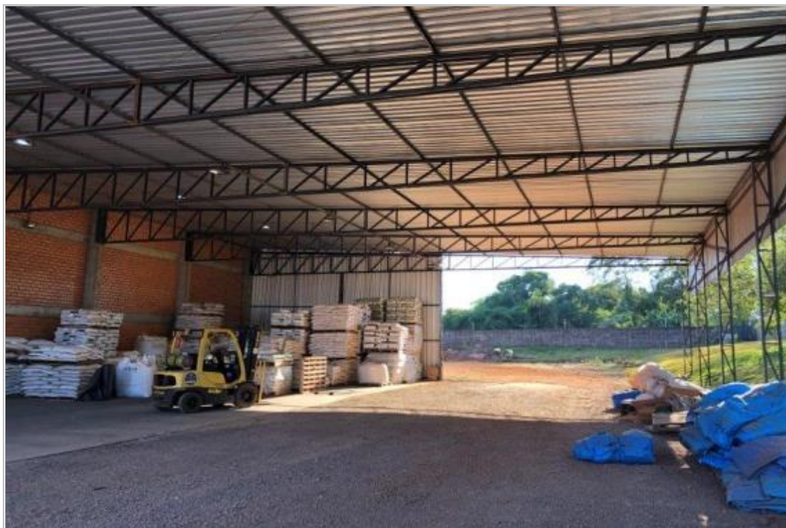
VISTA PARCIAL INTERNA – AMPLIAÇÃO DO GALPÃO 3
