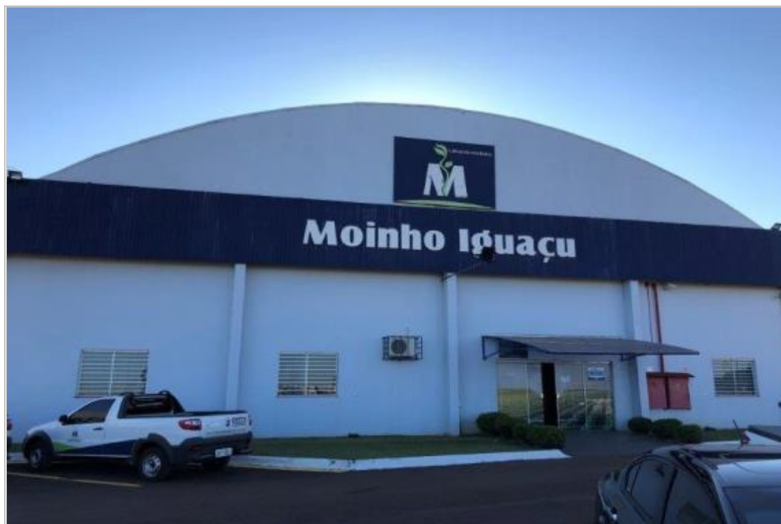
VISTA PARCIAL EXTERNA
