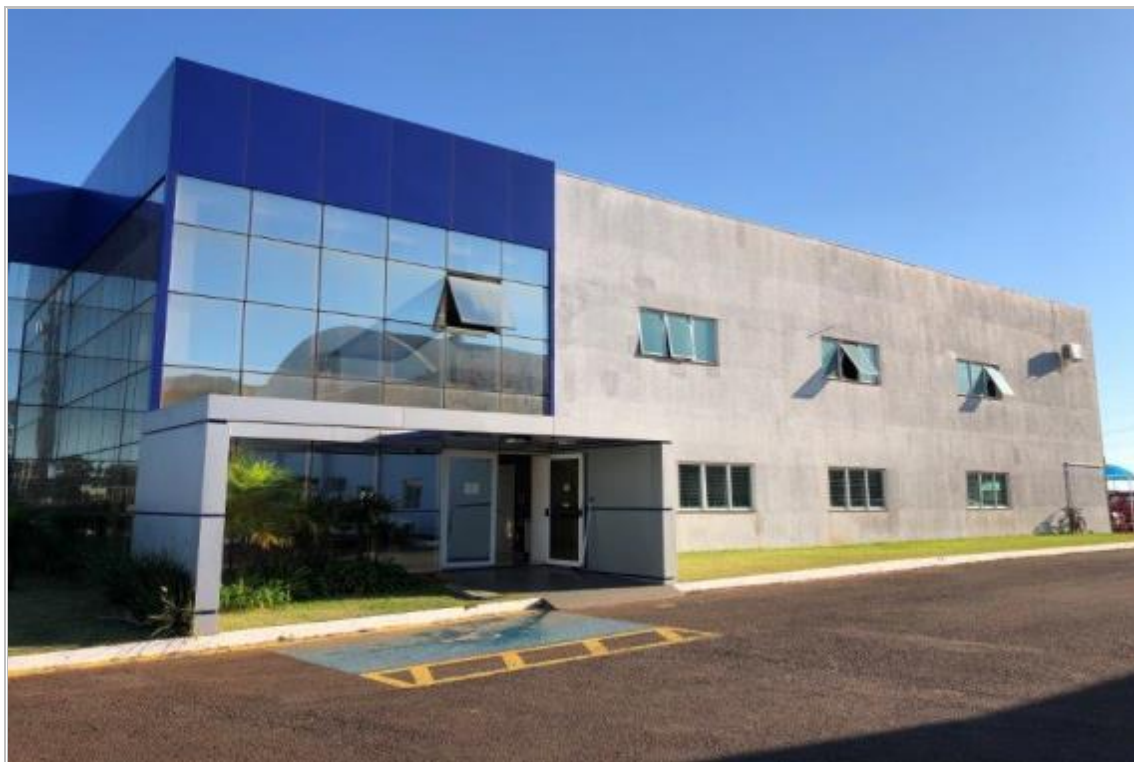
VISTA PARCIAL EXTERNA
