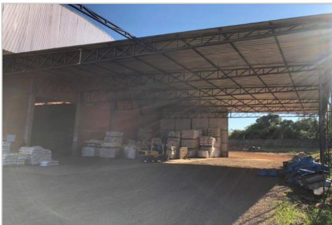
VISTA PARCIAL EXTERNA – AMPLIAÇÃO DO GALPÃO 3
