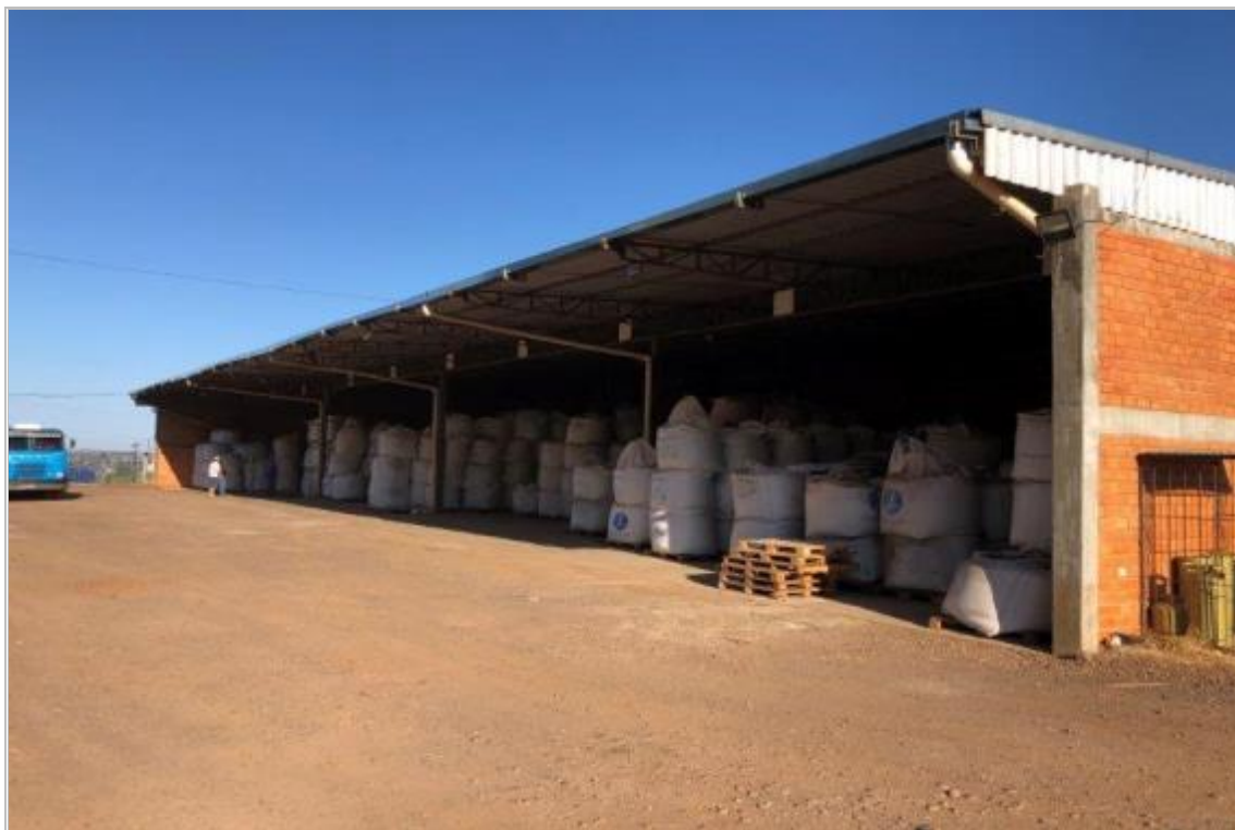
VISTA PARCIAL EXTERNA
