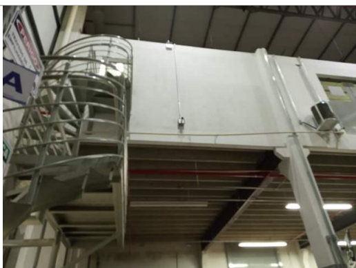
Escada de acesso ao mezanino
