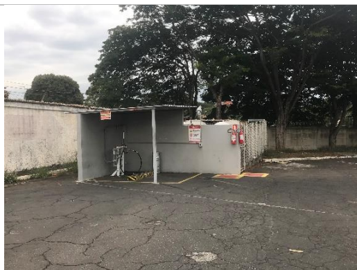
Ponto de Abastecimento das Empilhadeiras
