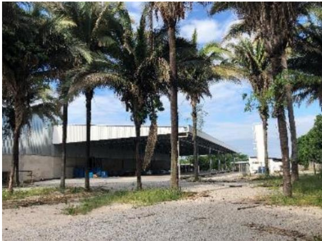
Vista Externa do Imóvel Avaliando.
