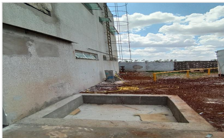
Prédio – Adm (Futuro elevador)
