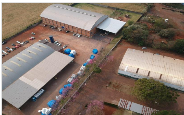
Galpão Insumos e Galpão Jd. Canadá – Vista Aérea
