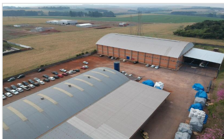
Galpão Insumos – Vista Aérea
