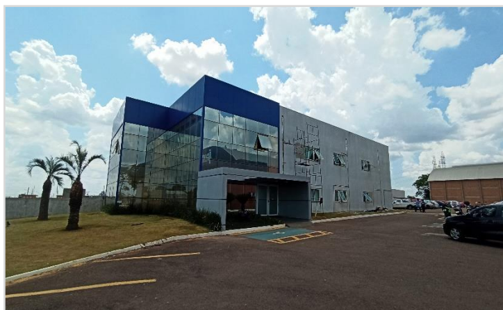
Área Externa – Prédio Administrativo
