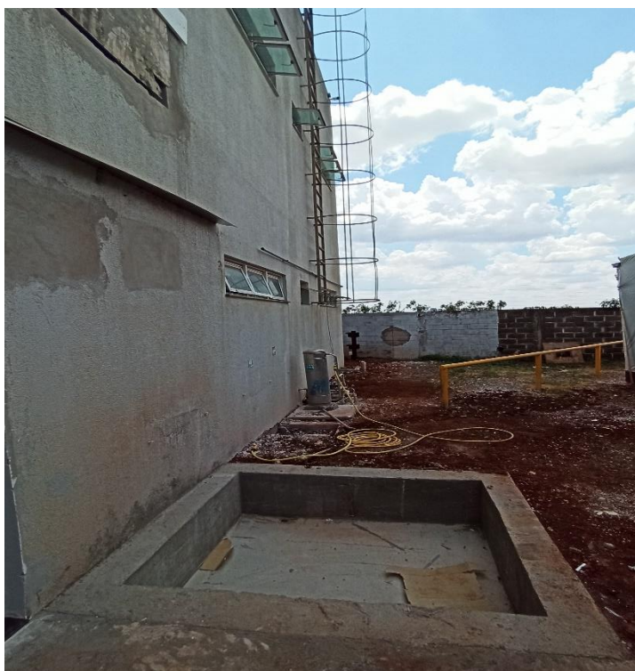
Instalação de elevador para acessibilidade
