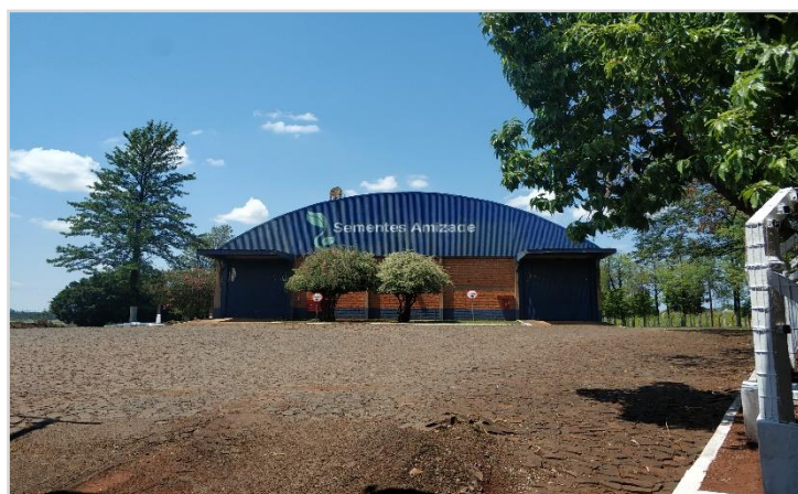
Fachada- Armazém Moega
