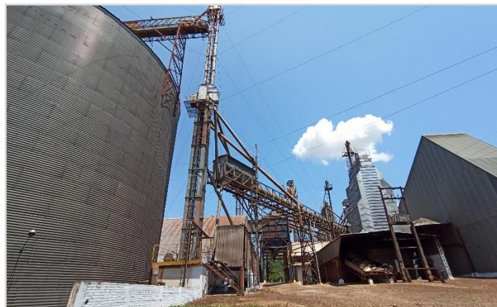
Silo, balança e Moega
