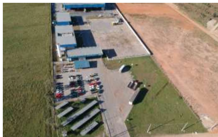
Vista Aérea Placas fotovoltaicas
