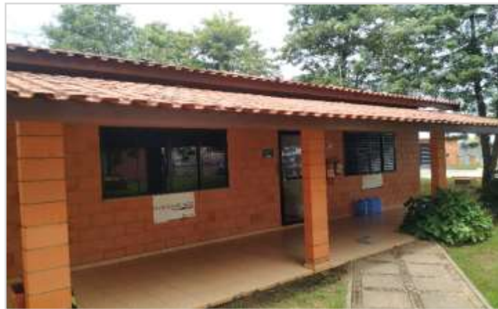
Depósito de Tintas
