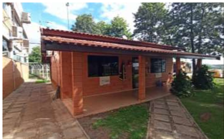
Depósito de Tintas
