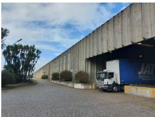
Vista da Fachada do Barracão.
