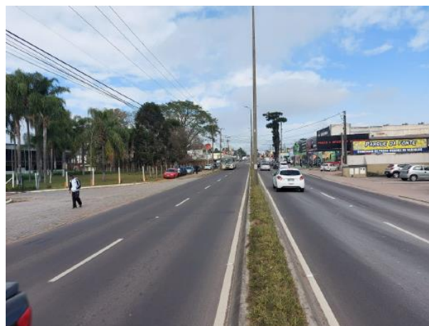
Avenida Rui Barbosa – Local do Imóvel Avaliando.
