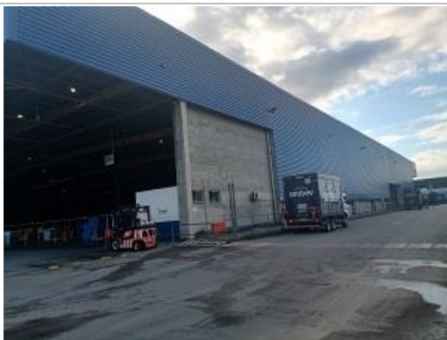
Fachada lateral do galpão
