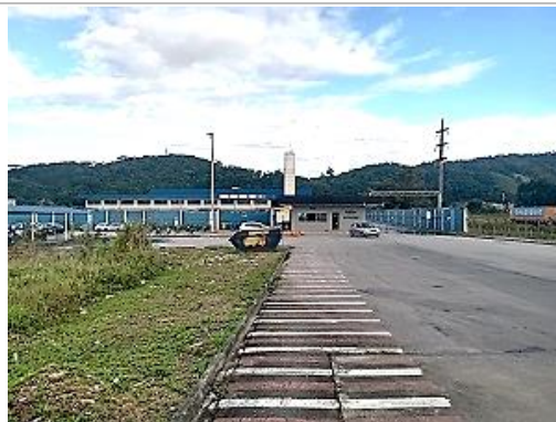
Acesso pela Rua Fermino Vieira Cordeiro
