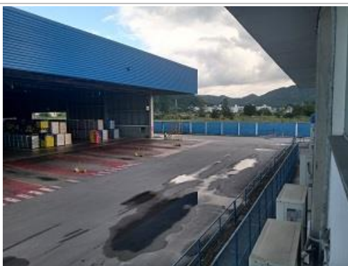
Fachada frontal do galpão
