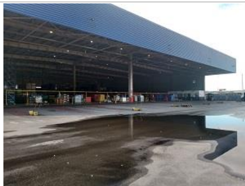
Fachada fundos do galpão
