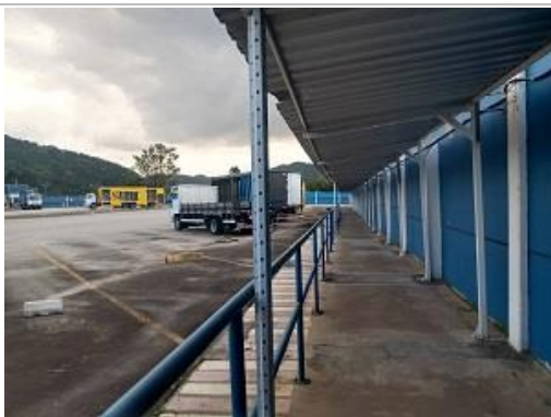
Acesso de pedestres
