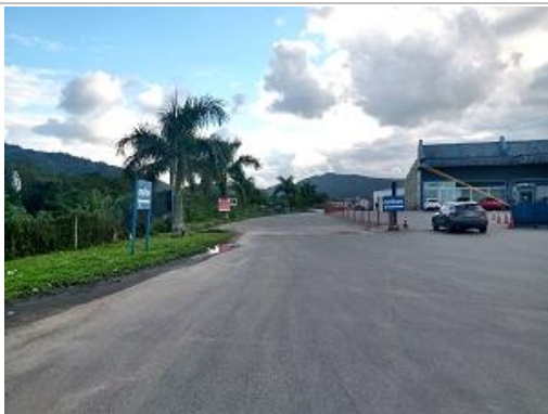
Acesso pela Rua Fermino Vieira Cordeiro
