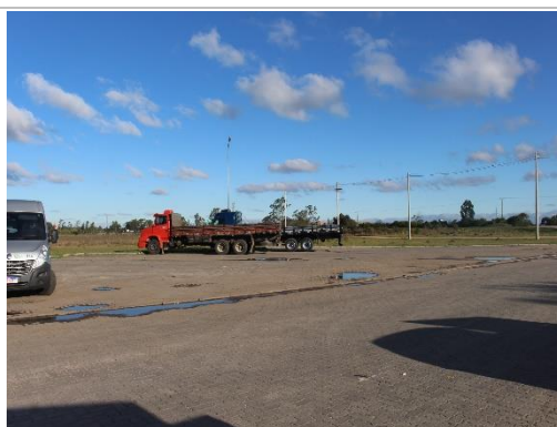
Vista Geral - Estacionamento
