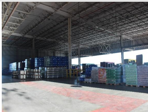
Vista Geral - Depósito
