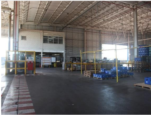
Vista Geral - Depósito
