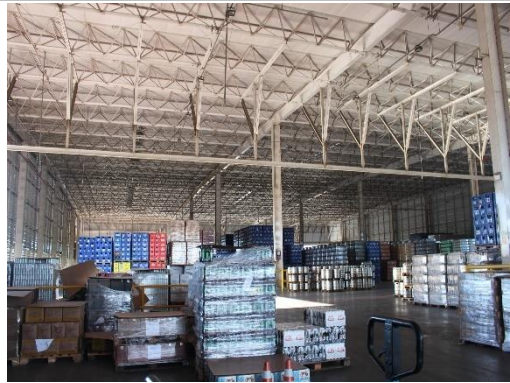
Vista Geral - Depósito
