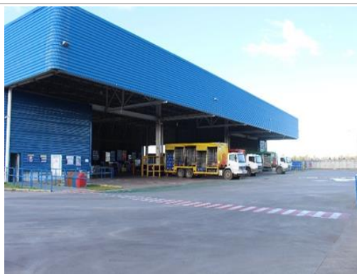
Vista Geral – Fachada do Galpão
