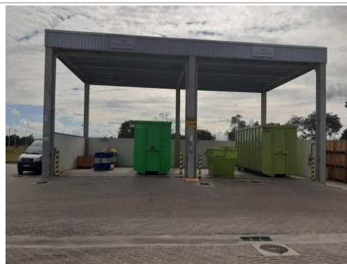
Central de resíduos
