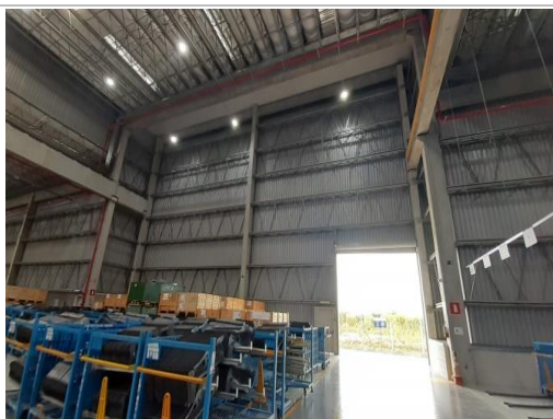
Área interna do galpão
