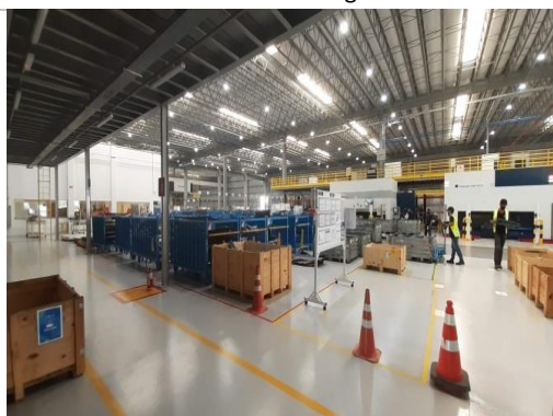
Área interna do galpão
