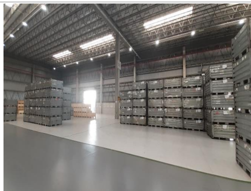
Área interna do galpão
