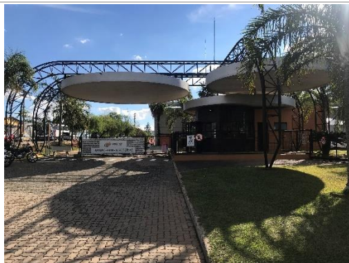
Vista Geral - Entrada
