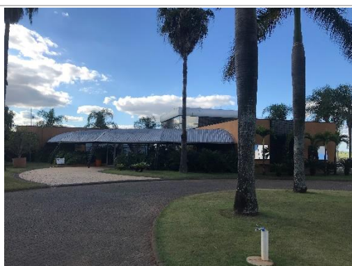
Vista Geral – Prédio Administrativo
