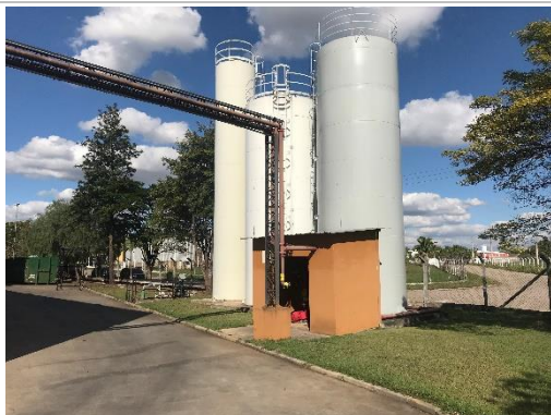
Vista Geral – Reservatórios de Água
