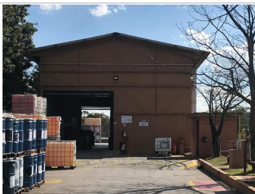
Vista Geral – Galpão de Apoio
