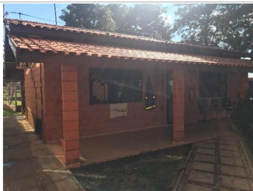
Vista Geral - Almoxarifado
