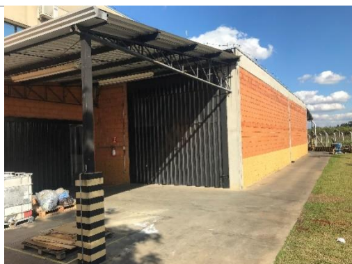
Vista Geral - Fachada
