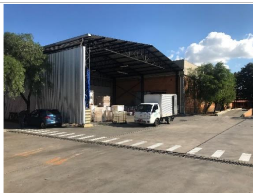
Vista Geral - Fachada
