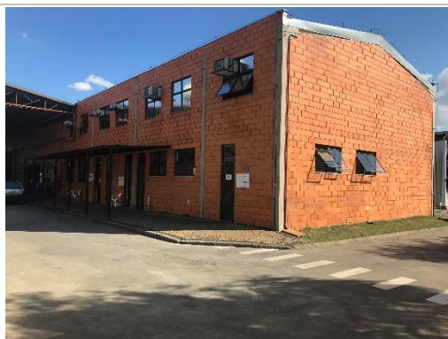
Vista Geral - Fachada
