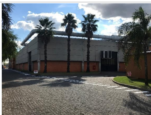
Vista Geral - Fachada
