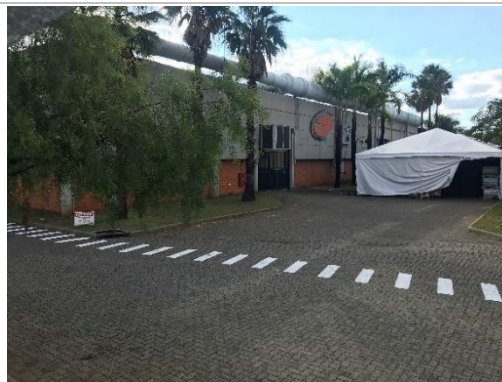
Vista Geral - Fachada
