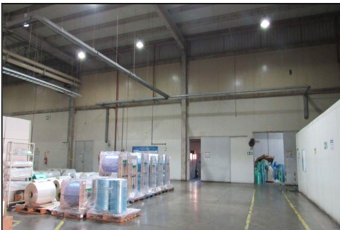
GALPÃO VISTA INTERNA
