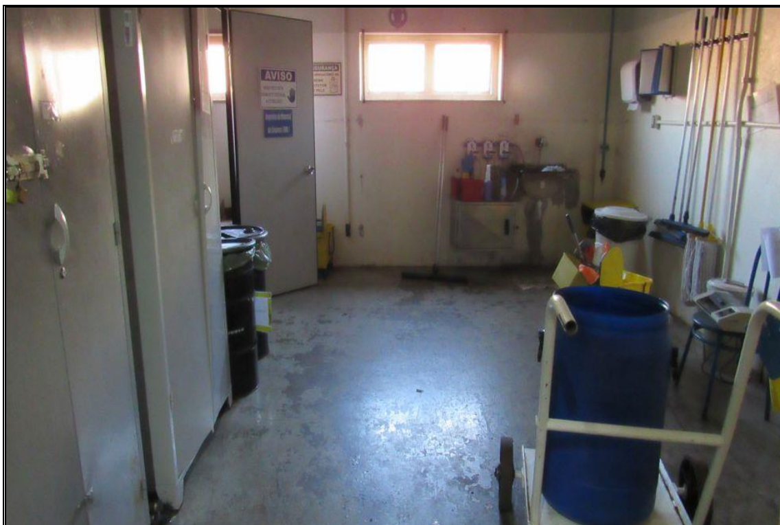
GALPÃO VISTA INTERNA - LAVAGEM
