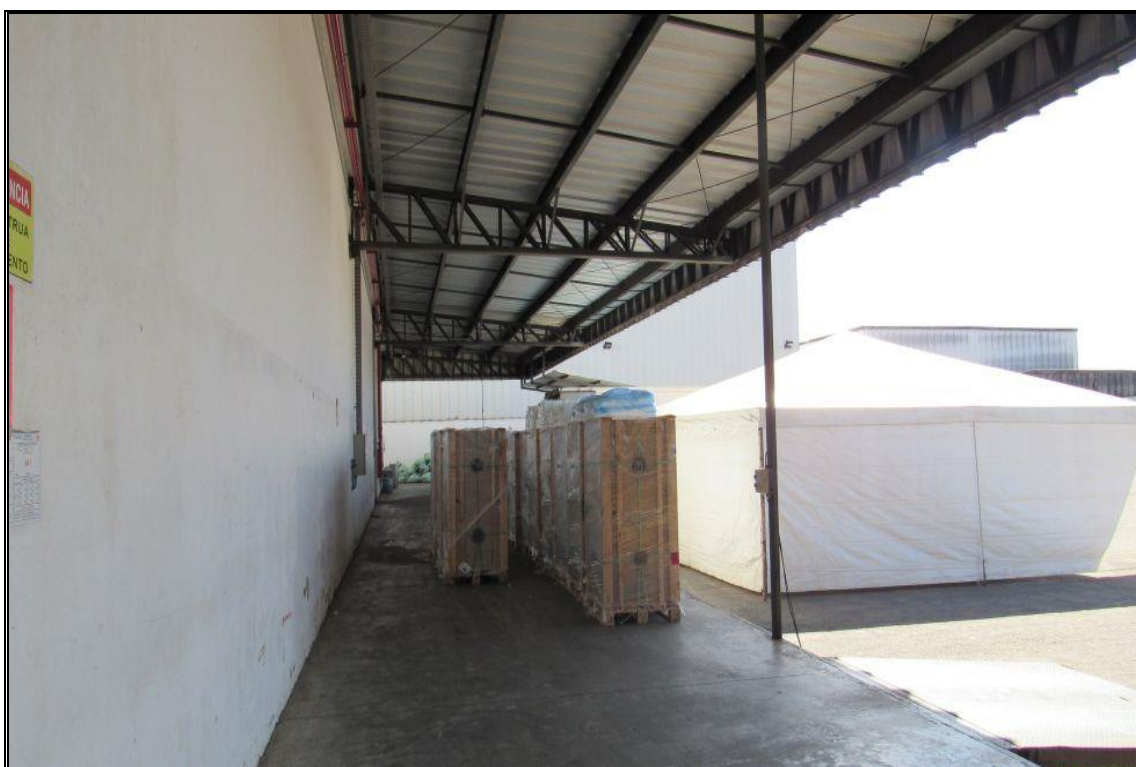
GALPÃO VISTA INTERNA - DOCAS
