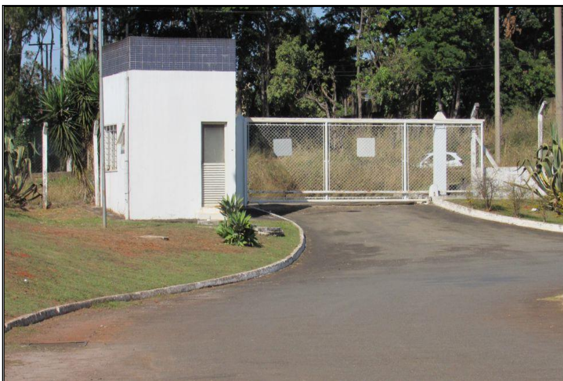
FACHADA PORTARIA DESATIVADA
