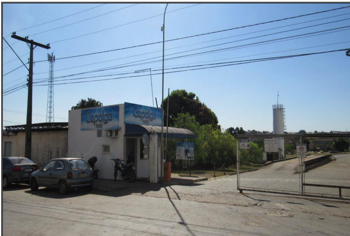
VISTA GERAL DA PORTARIA
