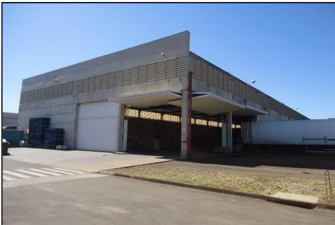
VISTA EXTERNA – DEPÓSITO 2
