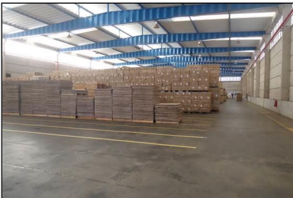
VISTA INTERNA – DEPÓSITO 2
