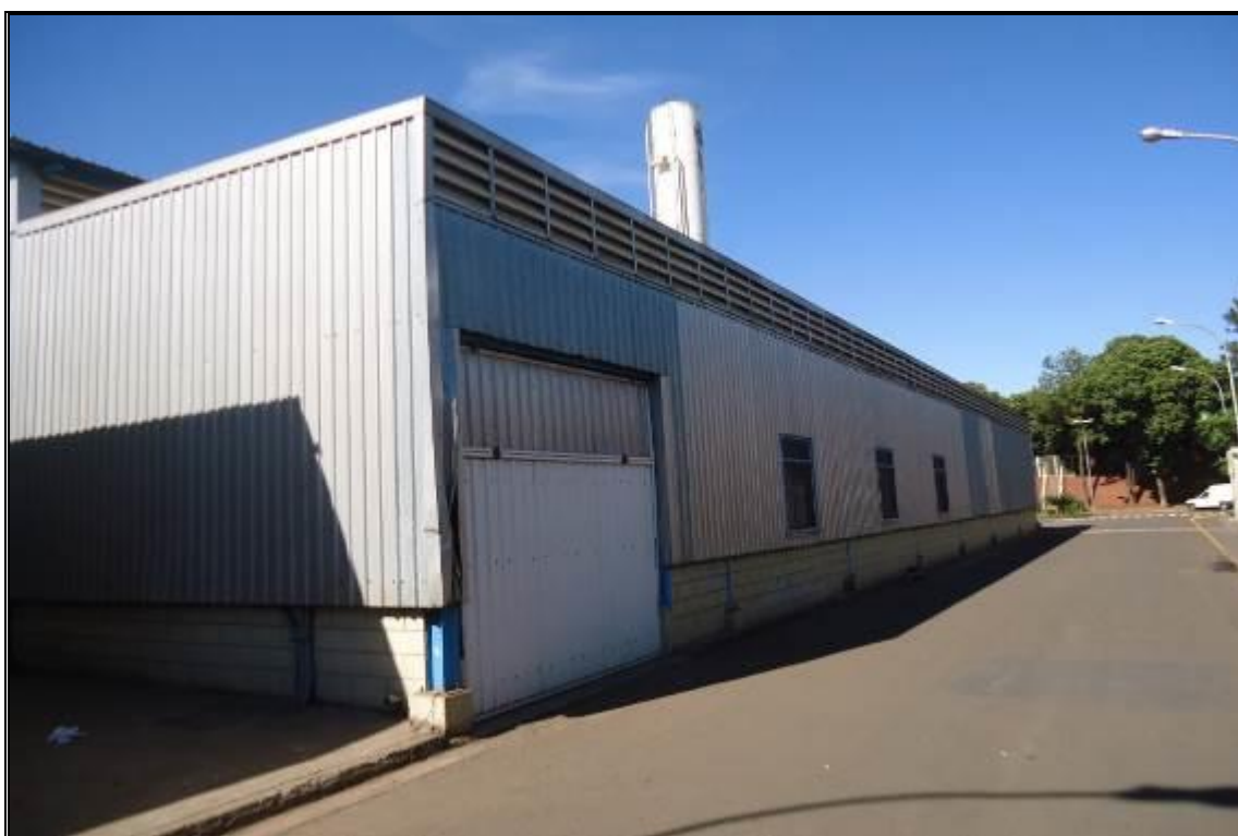
VISTA EXTERNA – DEPÓSITO 1
