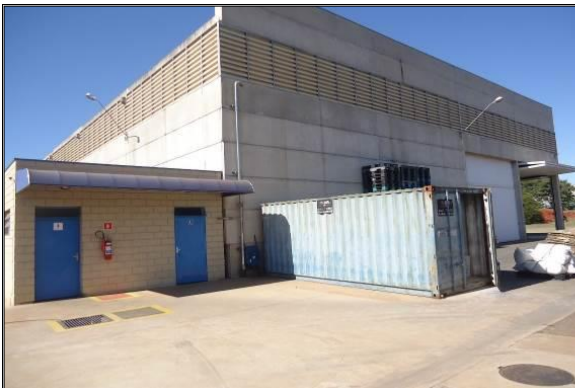
VISTA EXTERNA – DEPÓSITO 2
