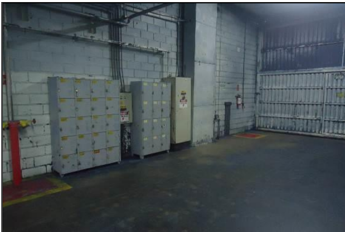
VISTA INTERNA – TECELAGEM 1
