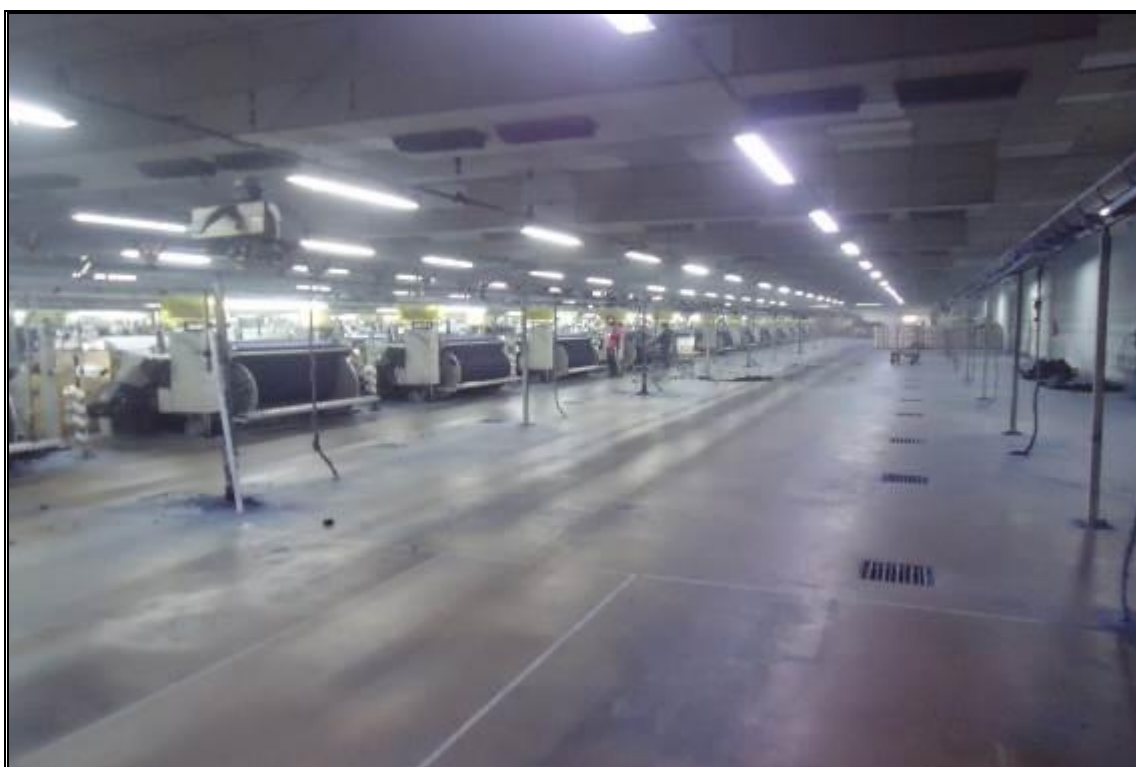
VISTA INTERNA – TECELAGEM 1
