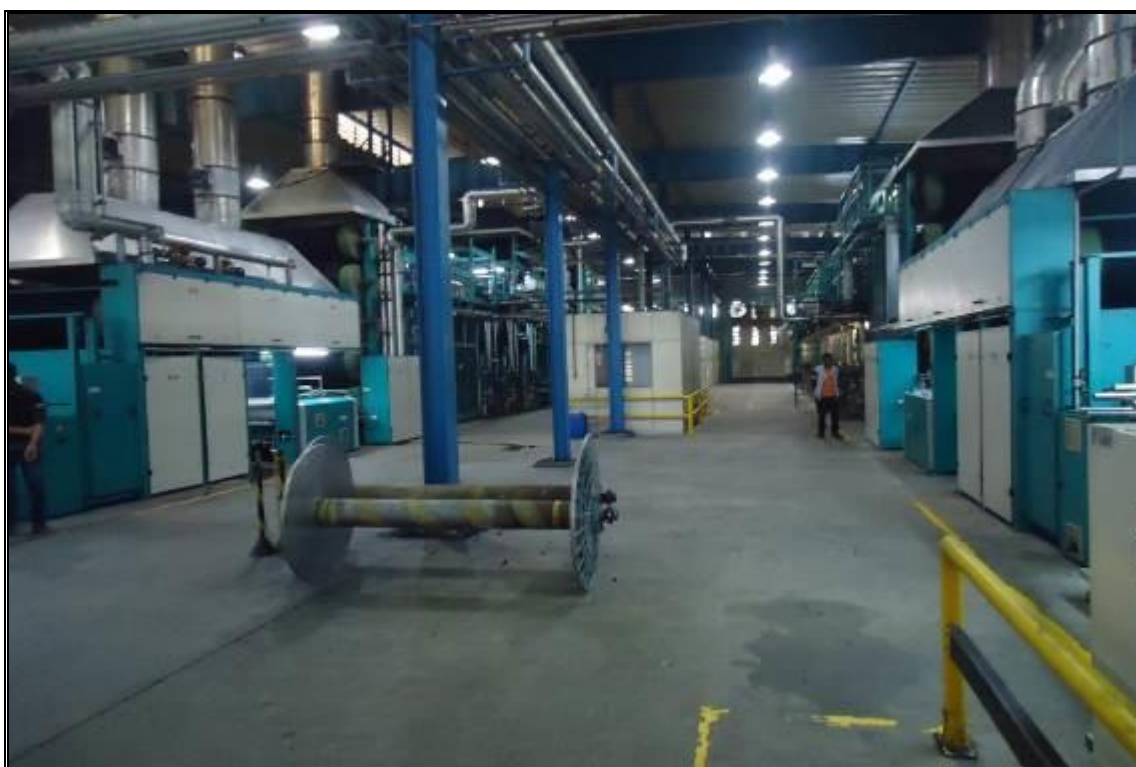
VISTA INTERNA – TECELAGEM 2
