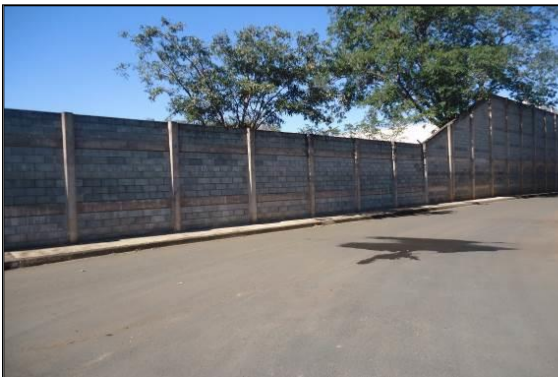
FECHAMENTO LATERAL EM ALVENARIA
