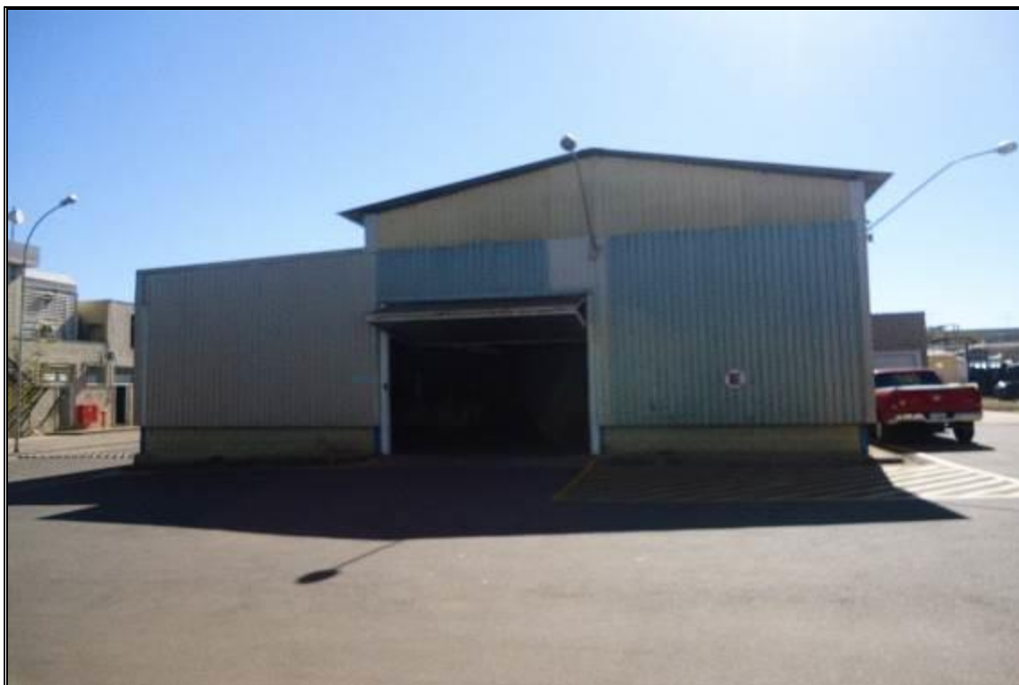
VISTA EXTERNA – DEPÓSITO 1
