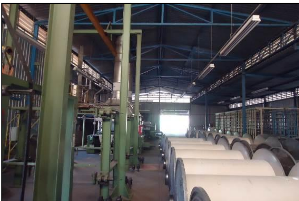
VISTA INTERNA – DEPÓSITO 1
