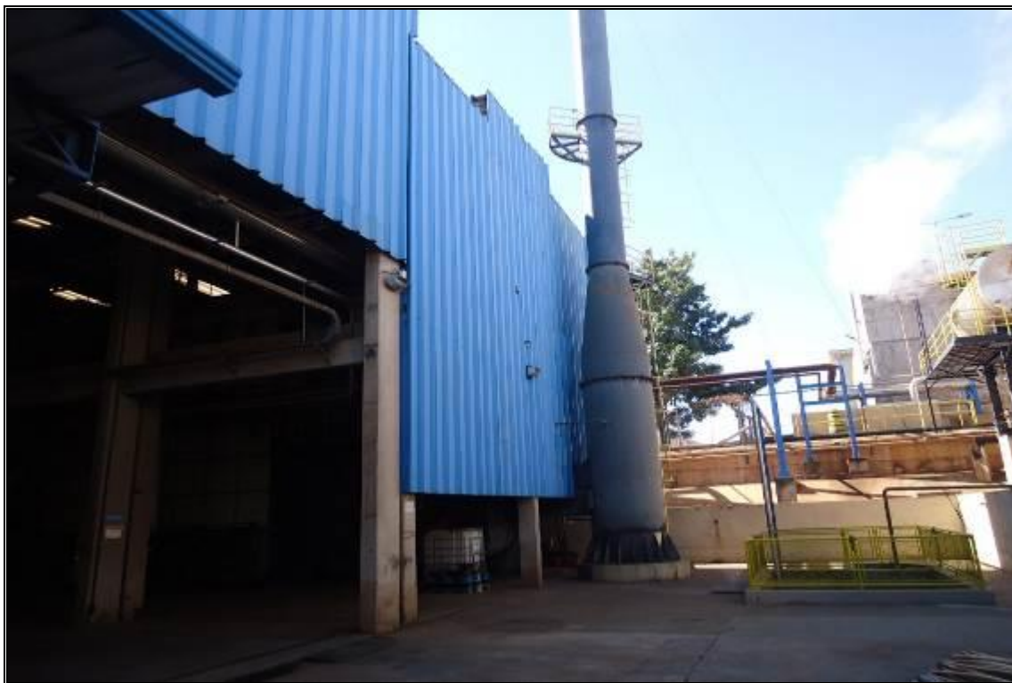
VISTA EXTERNA – CALDEIRAS
