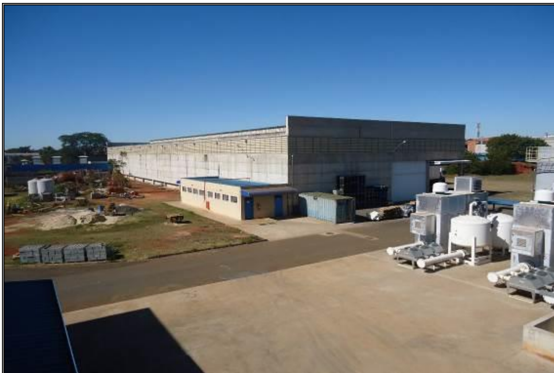
VISTA EXTERNA – DEPÓSITO 2
