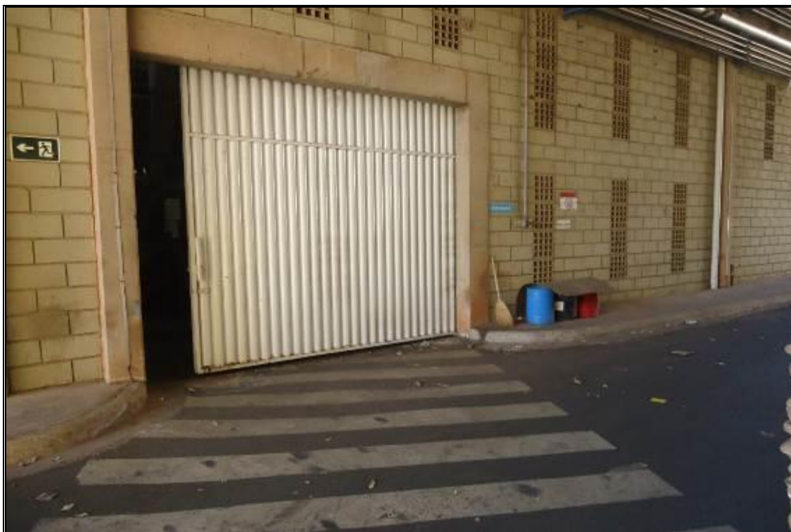
VISTA EXTERNA – TECELAGEM 2
