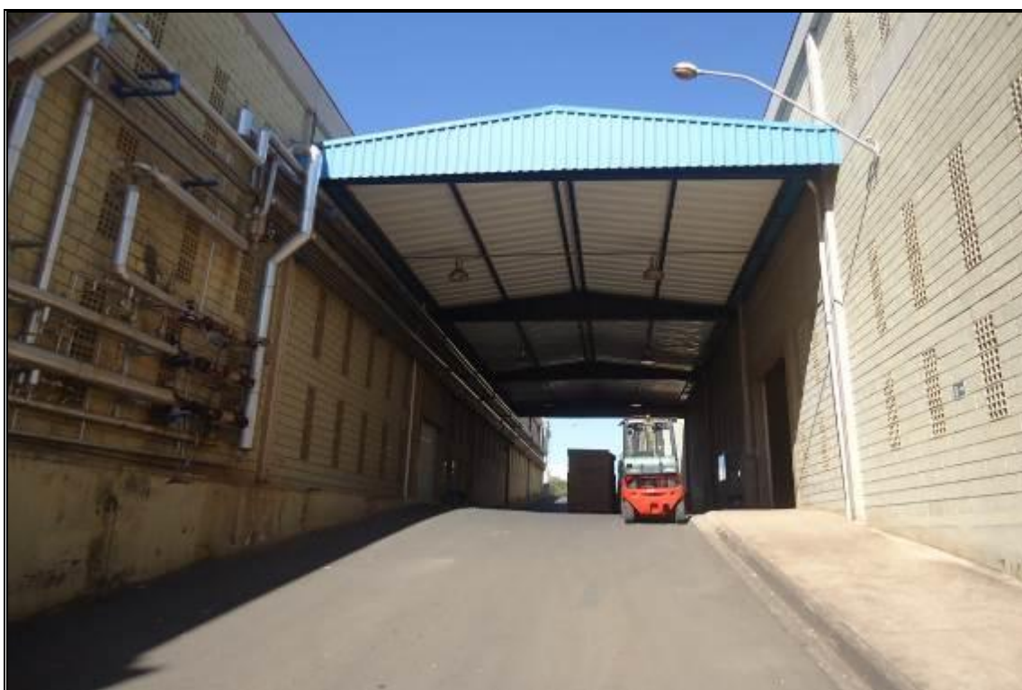
VISTA EXTERNA – SALA DE PANO
