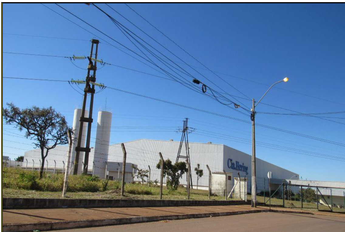
VISTA DO ACESSO
