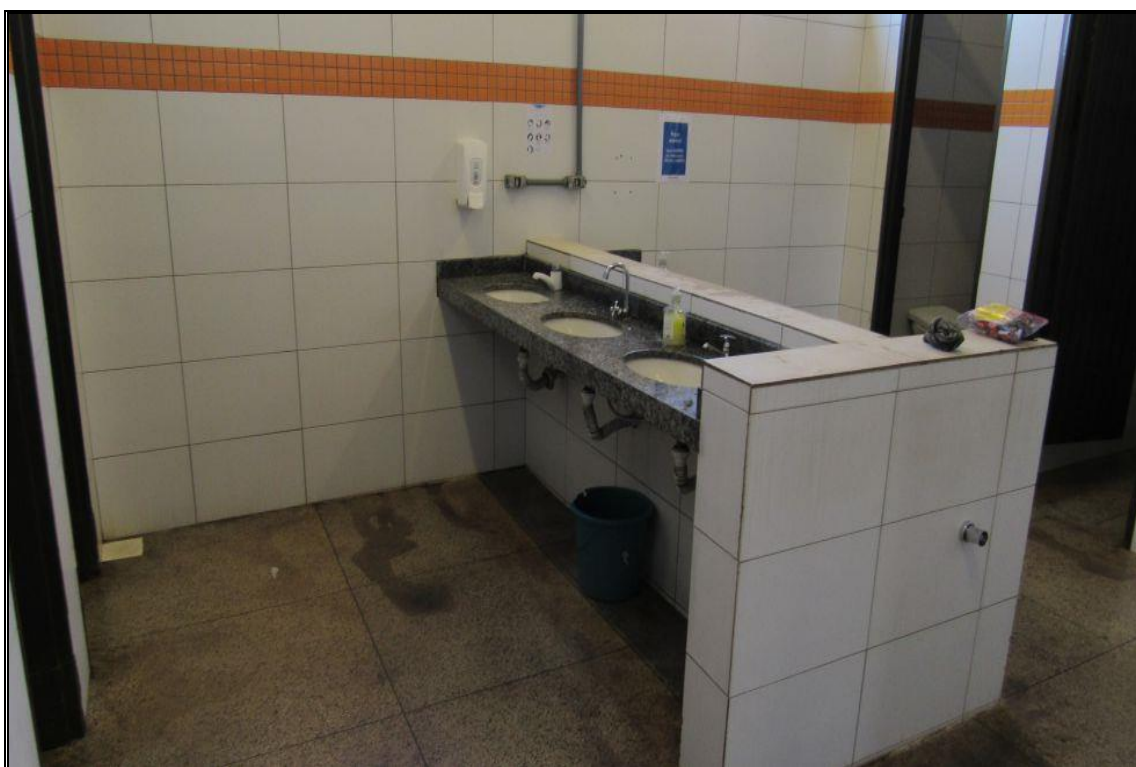
GALPÃO INTERNO - SANITÁRIOS
