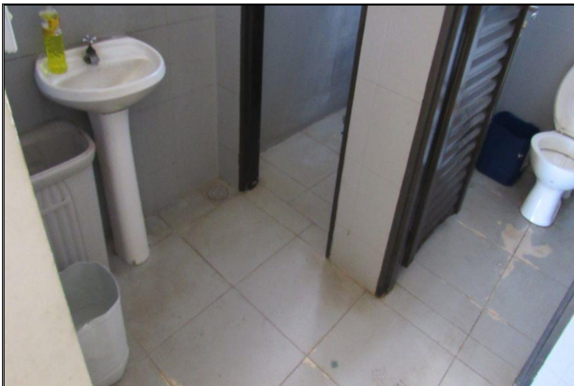
PRÉDIO APOIO TRANSPORTADORAS - SANITÁRIOS
