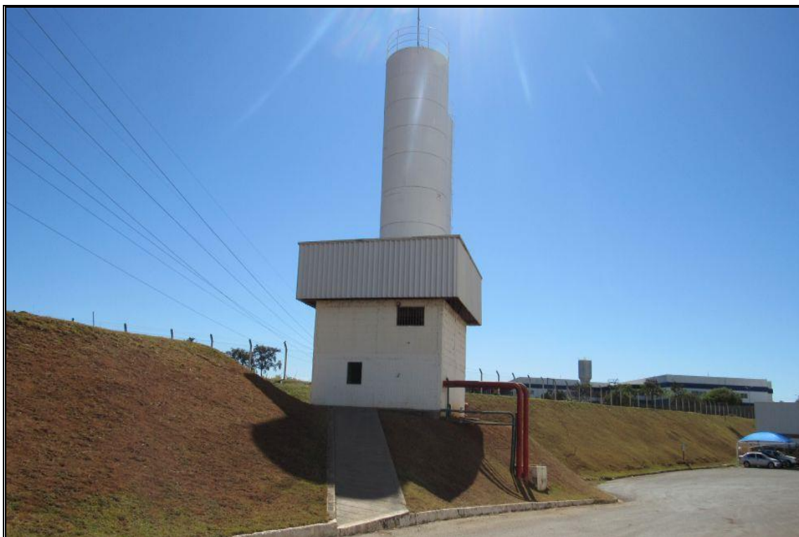
CASA DE BOMBAS
