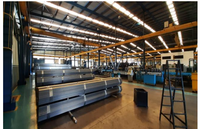
Características Internas do Imóvel Avaliando.
