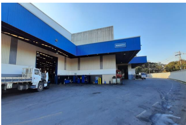
Características Internas do Imóvel Avaliando.
