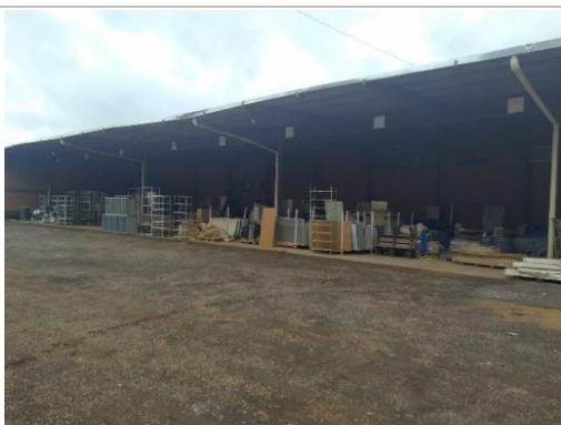
Vista Geral – Galpão 2
