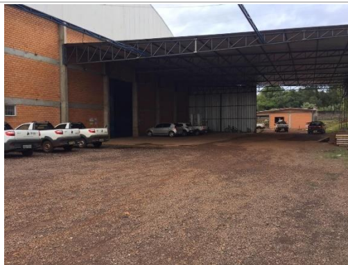
Vista Geral – Galpão 1
