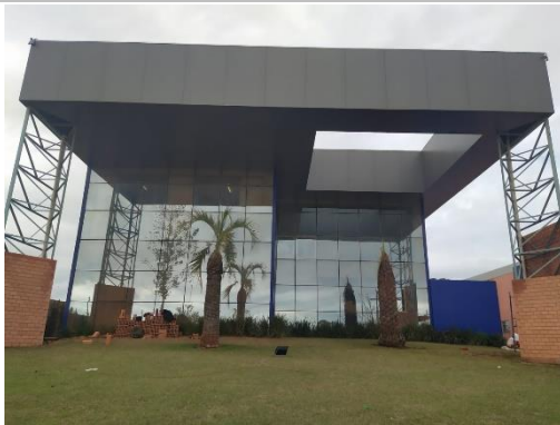
Vista Geral – Prédio Administrativo
