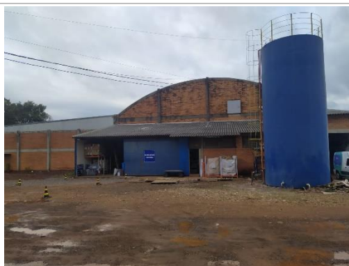
Vista Geral – Galpão 2
