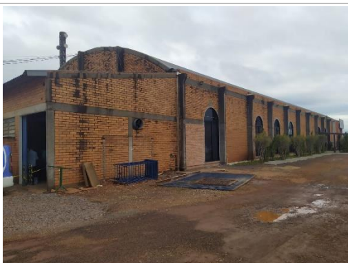
Vista Geral – Galpão 2
