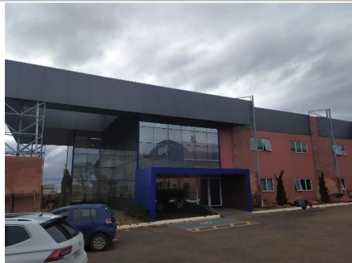
Vista Geral – Prédio Administrativo
