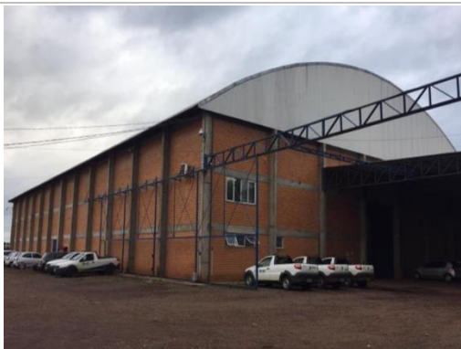
Vista Geral – Galpão 1
