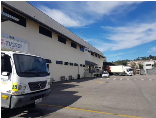
Vista da Fachada do Barracão.
