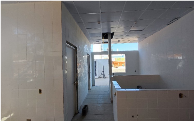
Prédio Adm - Cozinha
