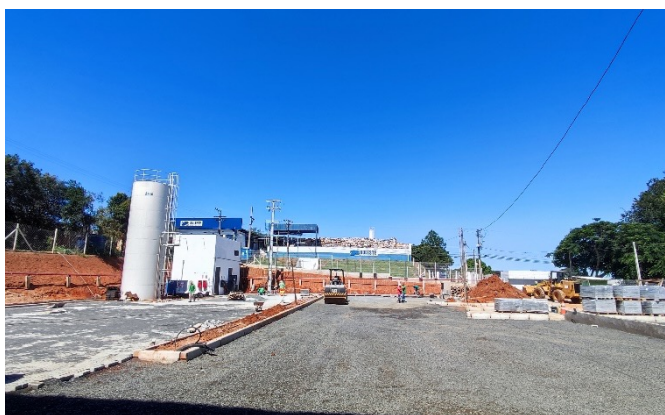
Área externa – Estacionamento
