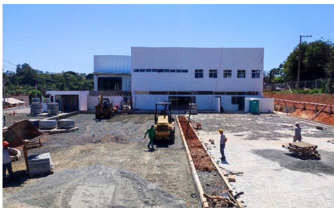
Parte posterior do galpão
